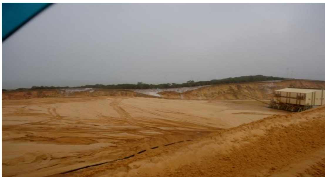
Foto 16 - Desmonte das dunas pelo processo de lavra úmida. Mina do Guajú, Mataraca, 2013. Fonte: Eliane Marques
