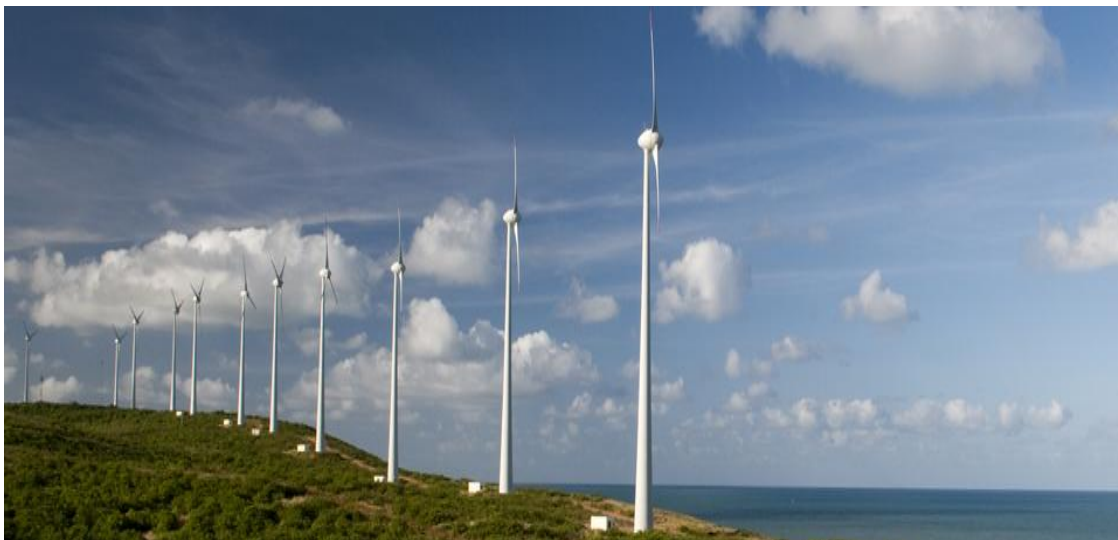
Foto 9 - Parque Eólico Millennium. Vista Panorâmica. Foto: Site da Pacific Hydro
