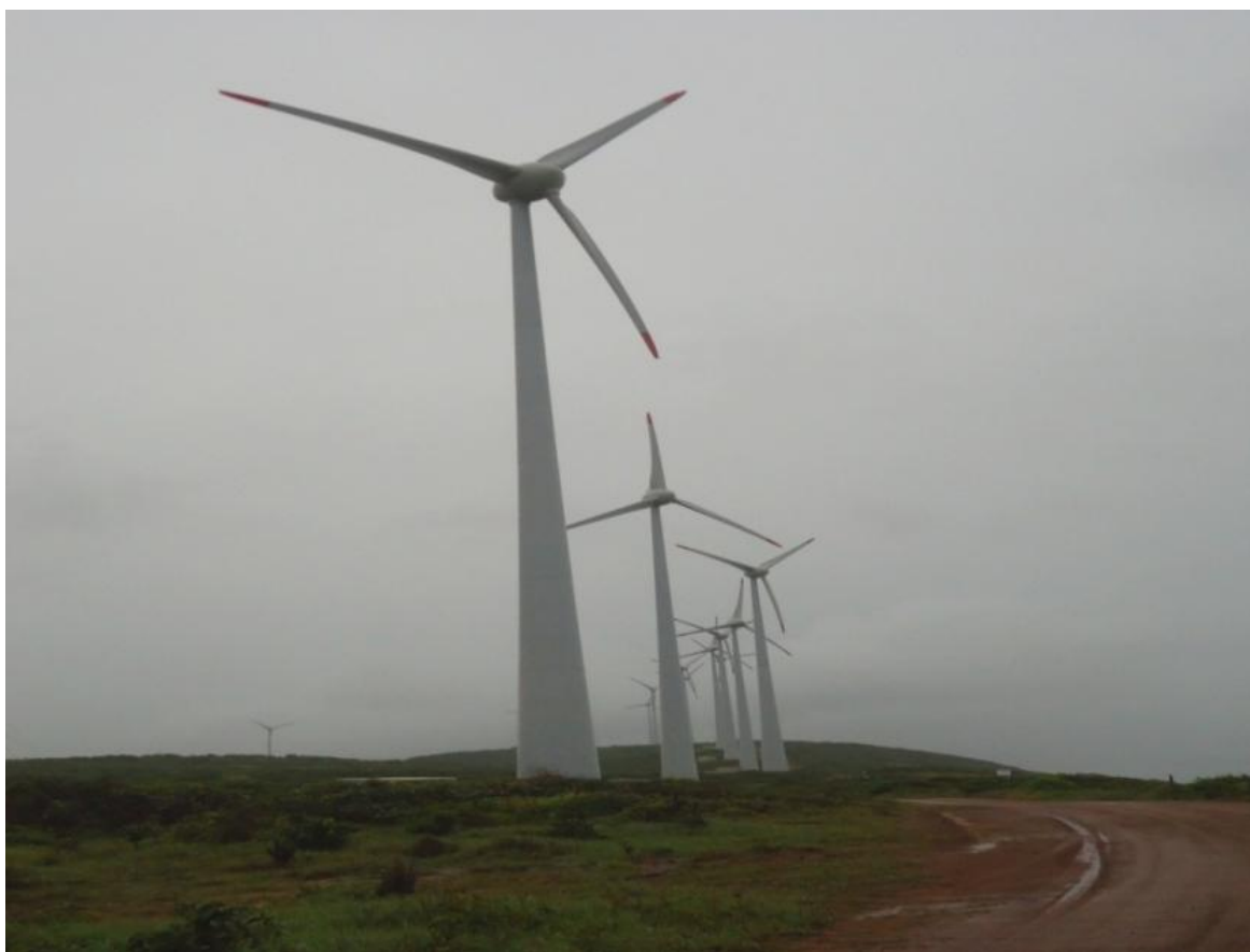
Foto 11 - Torres de energia eólica (aerogeradores) e estradas abertas para sua instalação. Mataraca, 2013. Fonte: Eliane Marques.
