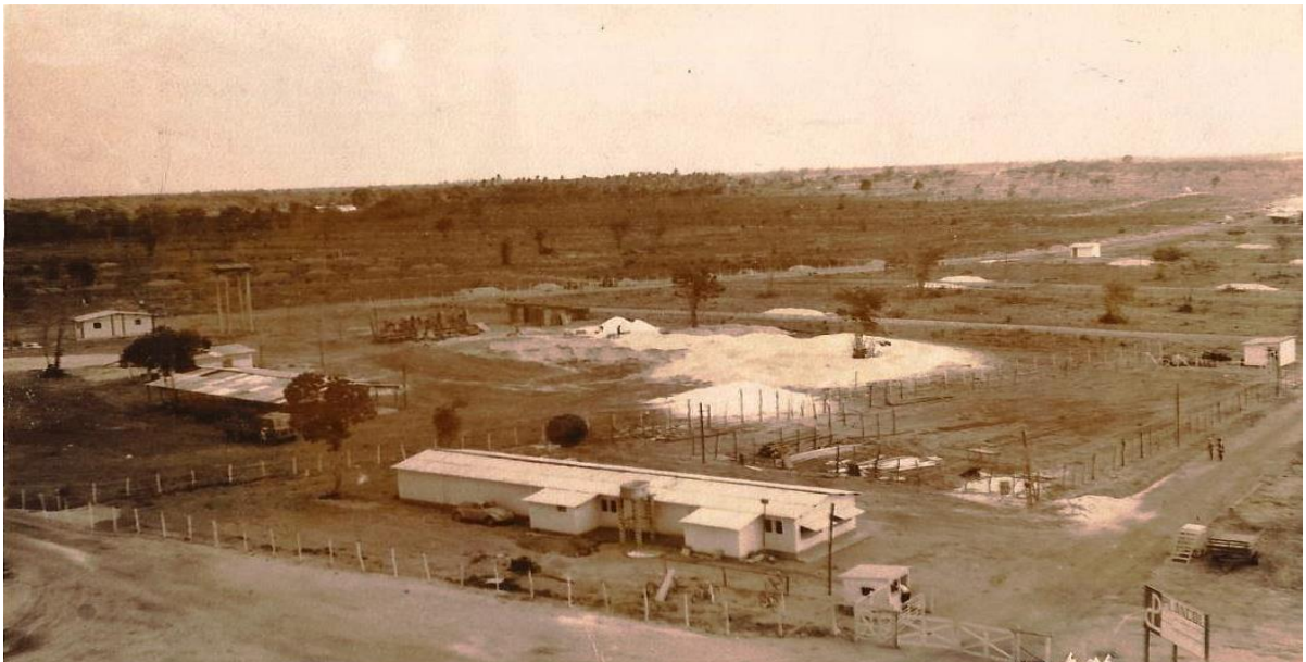
Fotografia 02: Início do canteiro de obras - 1983.
