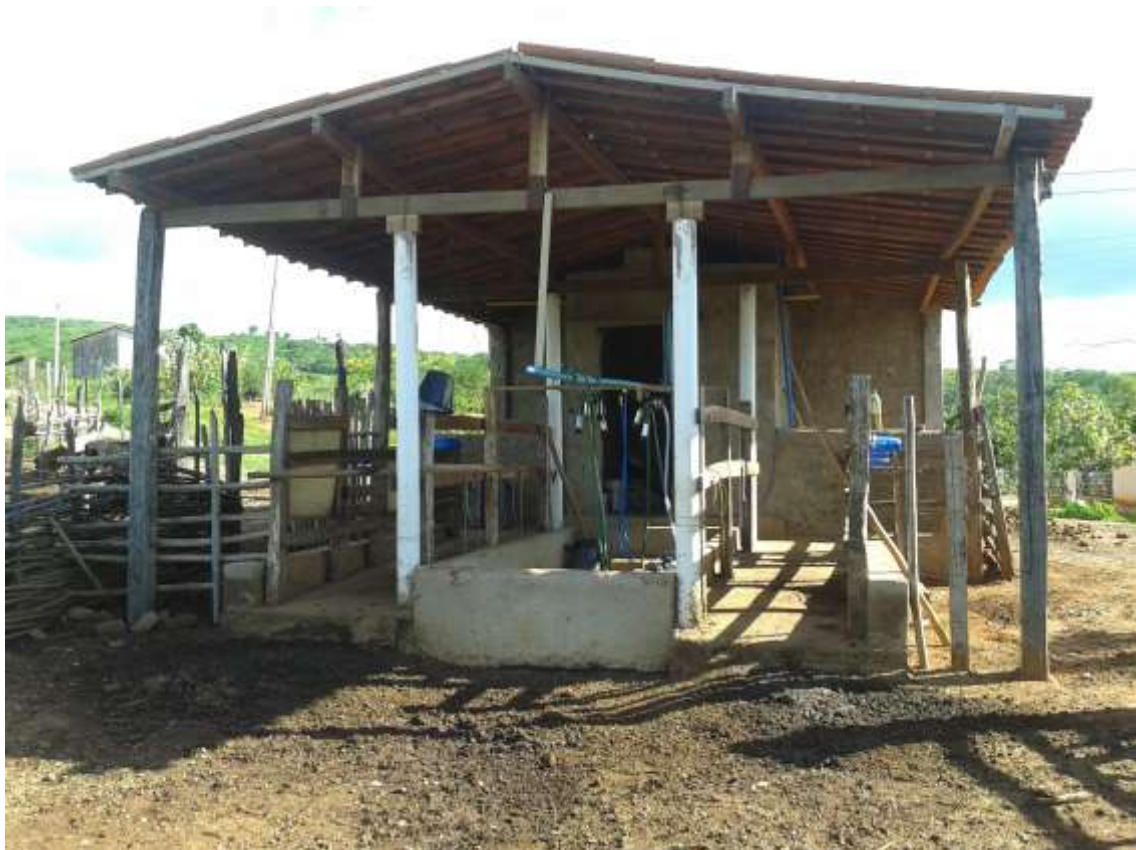
Sala de ordenha em propriedade no município de Bonito de Santa Fé
