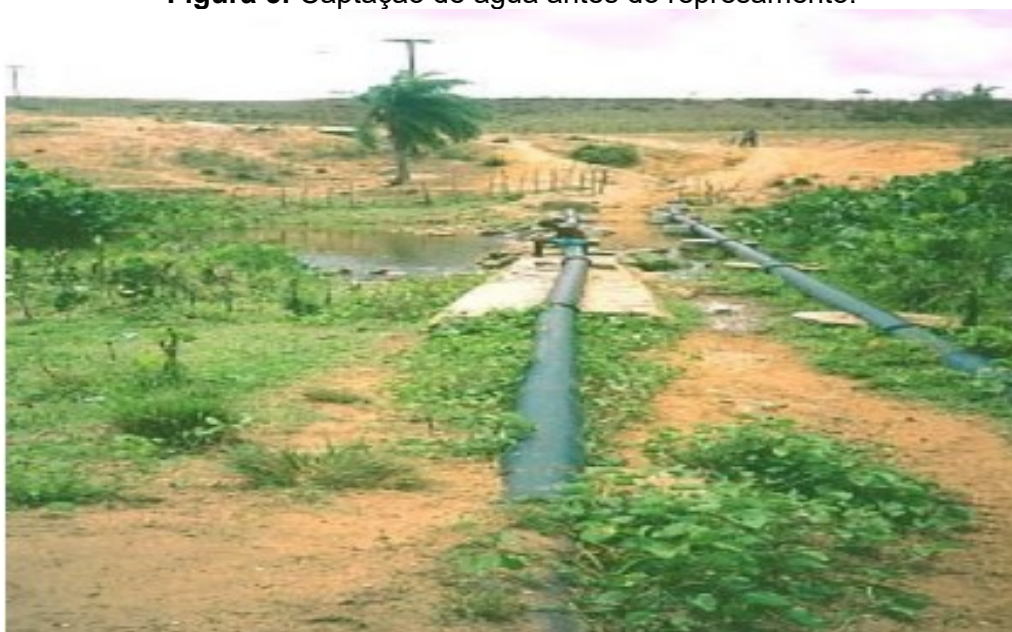
Figura 5: Captação de água antes do represamento.
