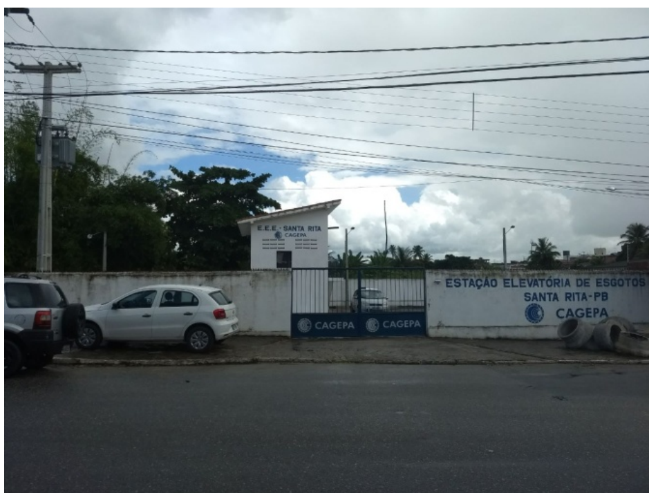
Figura 14: Estação de tratamento de Efluentes.
