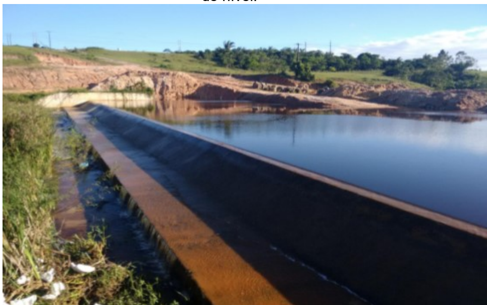
Figura 6: Captação de água após a construção da barragem de regularização de nível.
