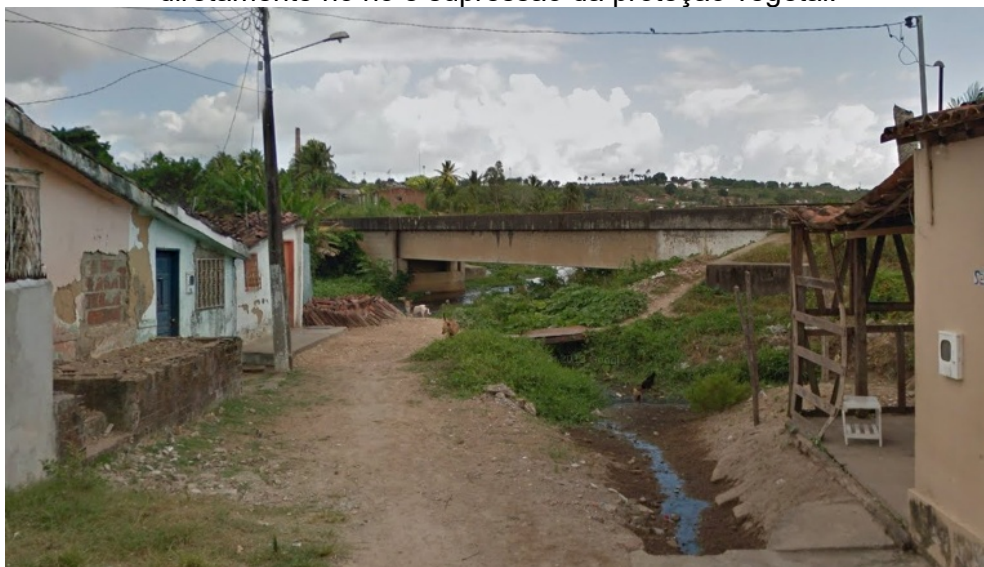
Figura 12: Ocupações nas margens do Rio Tibiri/Preto, despejo de efluentes diretamente no rio e supressão da proteção vegetal.
