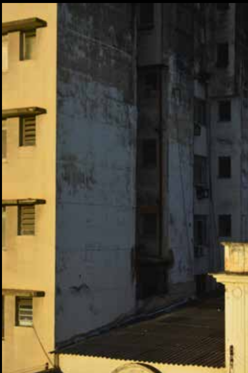
Figura 109: vista externa do 3º piso do Sobrado
