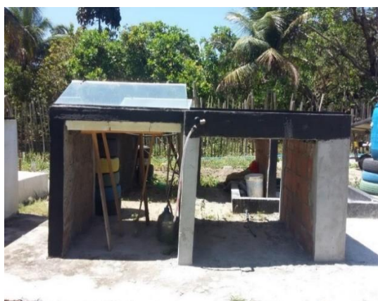
Figura 33 - Lateral oeste da estrutura.
