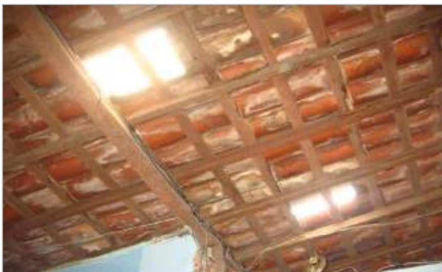
Figura 34: Coberta em telha cerâmica com algumas telhas de vidro
