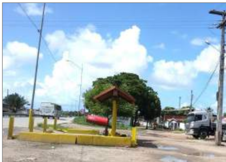
Figura 65: Ponto de parada de ônibus reformado
