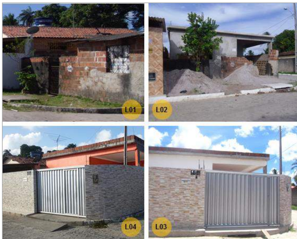
Figura 68: Casa em processo de manutenção e reforma
