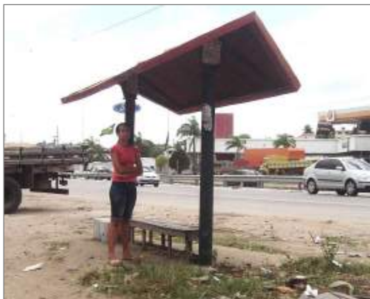
Figura 64: Ponto de parada de ônibus antes da reforma
