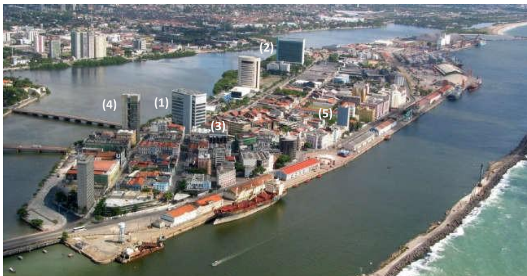
Figura 13– Edifícios que rompem com o gabarito do Bairro do Recife, construídos na década 1960.
