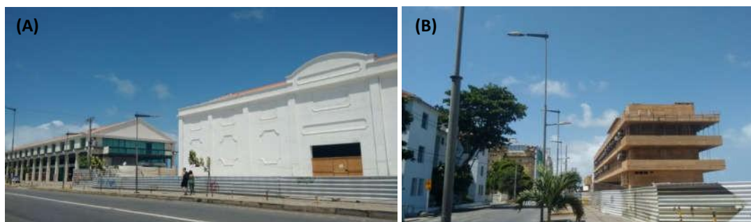
(A) - Museu Cais do Sertão, armazém 11 – lado norte; (B) - Empreendimento “Armazéns do Porto” – lado sul, armazém 13. Fonte: arquivo da autora (2015);
