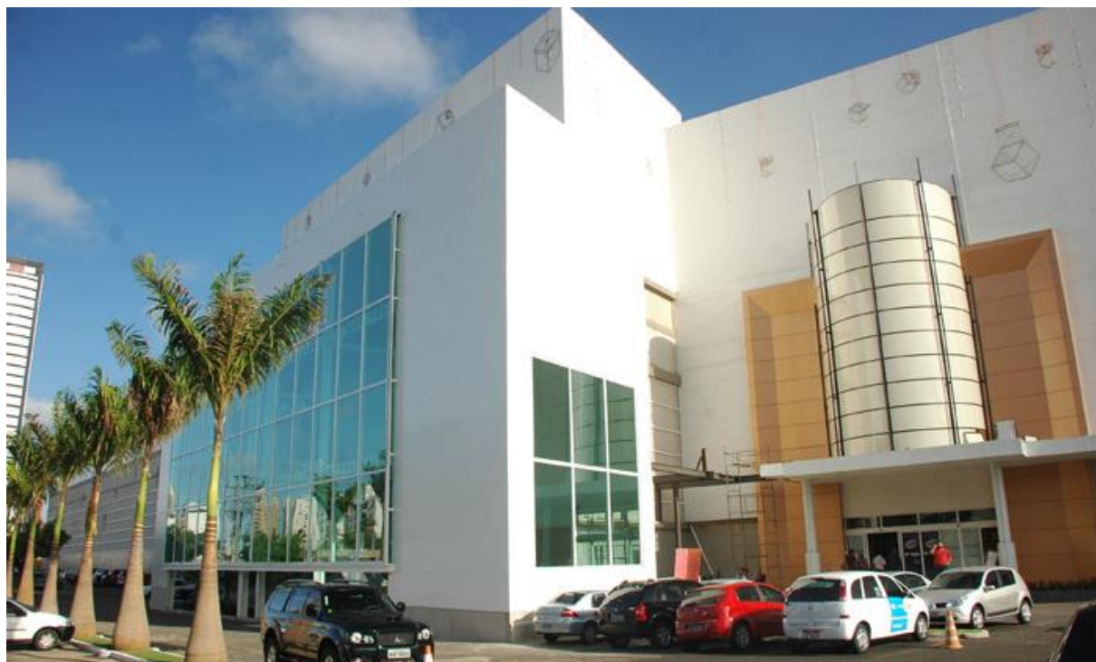
Figura 10 - Manaíra Shopping, primeiro shopping center instalado em João Pessoa. Fonte: PARAÍBA ONLINE (2016). Disponível em: < http://goo.gl/E0wAiI >. Acesso em 20 jun. 2016.
