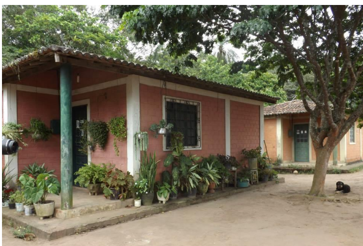
Figura 15 -Vila de casas do Projeto do Governo Federal na comunidade Chã de Jardim
