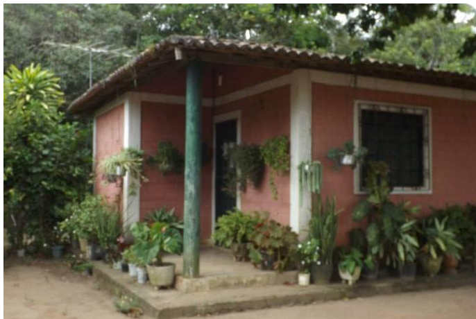
Figura 37 - Casa construída pelo Projeto do Governo Federal na comunidade Chã de Jardim
