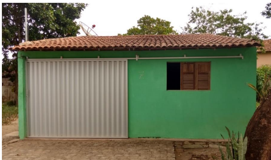
Figura 36 - Casa de alvenaria na comunidade Chã de Jardim
