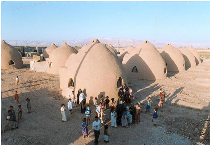
Figura 7 – Cidade Hesperia (EUA), o maior conjunto construído de superadobe
