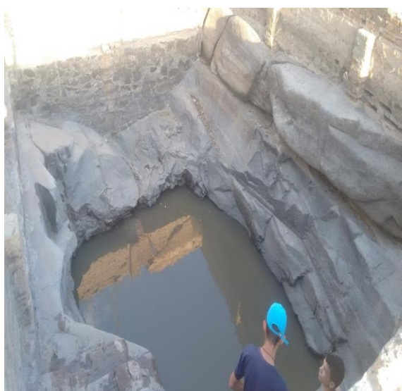
Figura 05 – Fonte d’água que dá nome a comunidade Olho D’água do Padre. Registro realizado em fevereiro de 2017.
