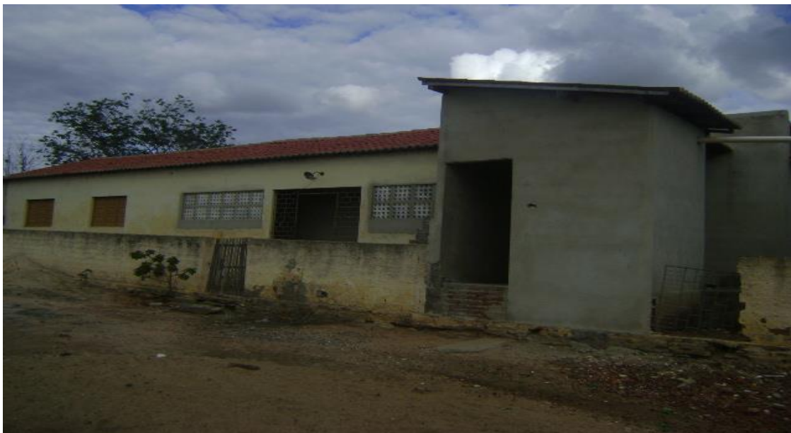
Figura 12: Escola da comunidade Caititu que estava sendo reformado antes da instalação do conflito territorial. Registro realizado em dezembro de 2016.
