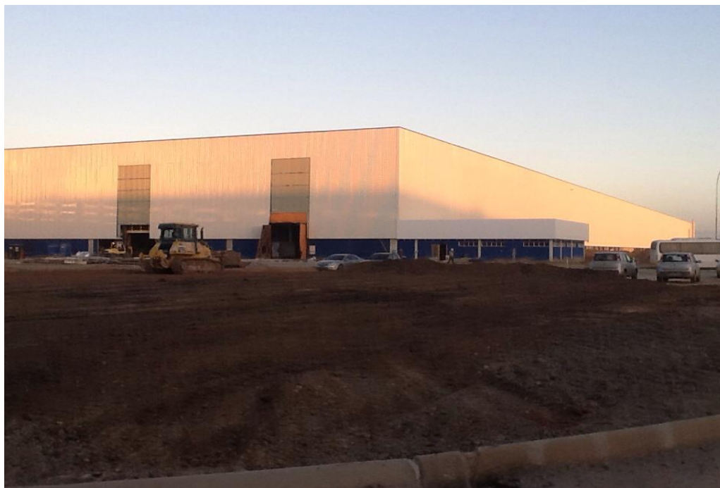
Foto nº. 22 – Fiat/Crhysler/ Jeep Goiana em construção.
