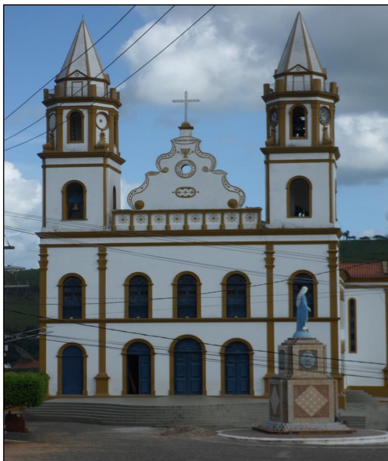
Figura 2: Igreja Matriz de Nossa Senhora do Livramento, 2016
