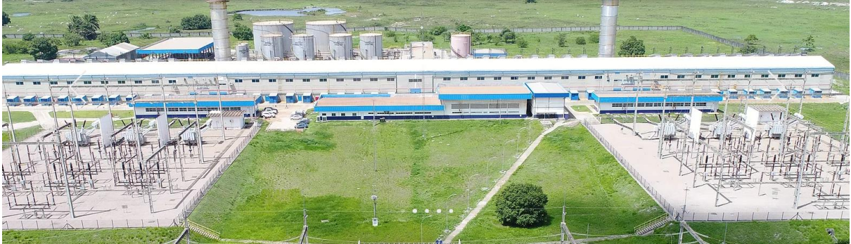
Figura 3 – Vista Aérea da Planta da EPASA
