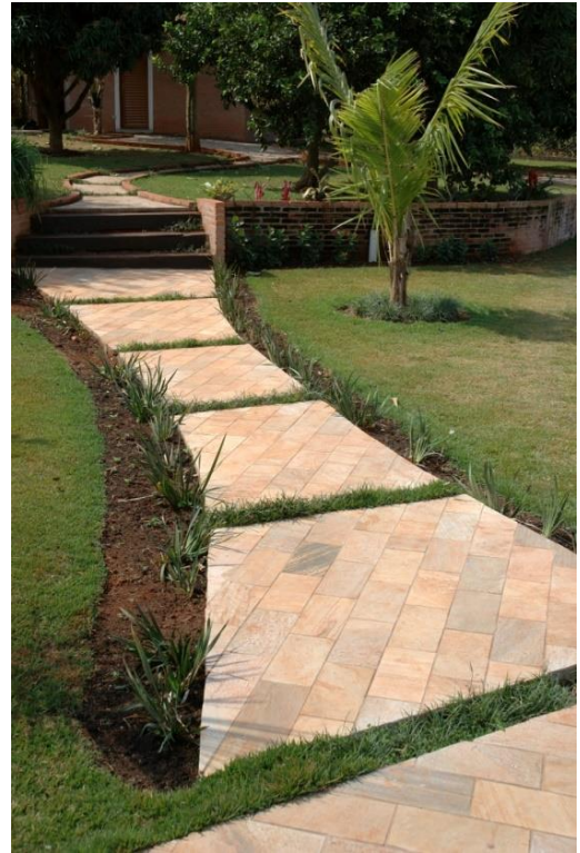
Figura 2 Aplicação do quartzito no piso em formato de lajota. Fonte: http://www.ltorquato.com.br/imagens/dicas/1216853003.jpg
