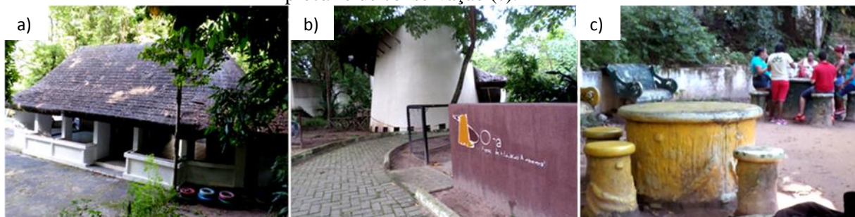
Figura 48: Fotos de equipamentos do Parque Zoobotânico Arruda Câmara fora de funcionamento (respectivamente, a: Espaço Jequitibá, b: OCA) e área de piquenique em estado precário de conservação (c).
