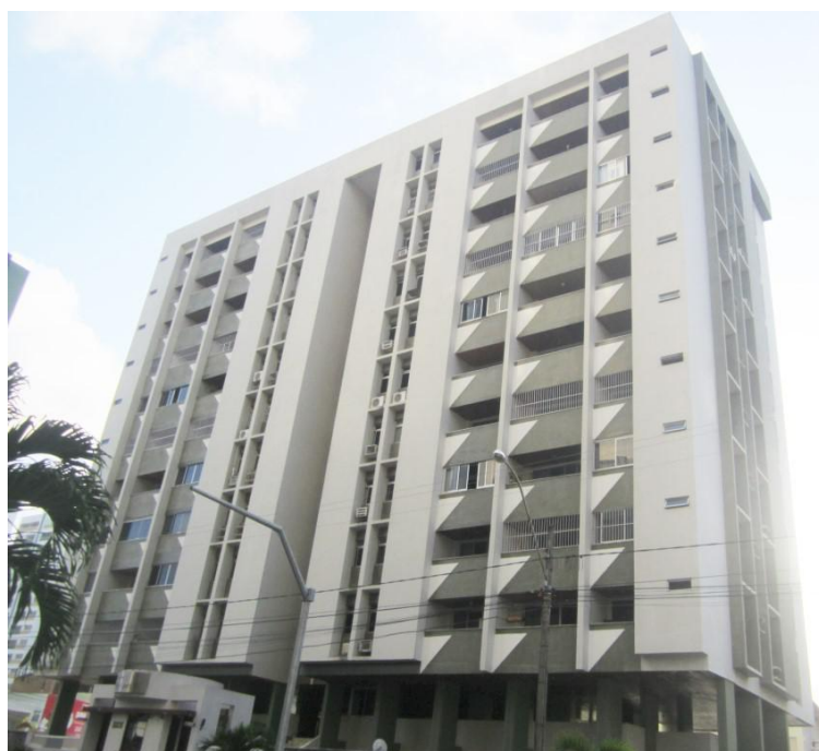
Figura 53: Edifício Clarissa VI em 2015
