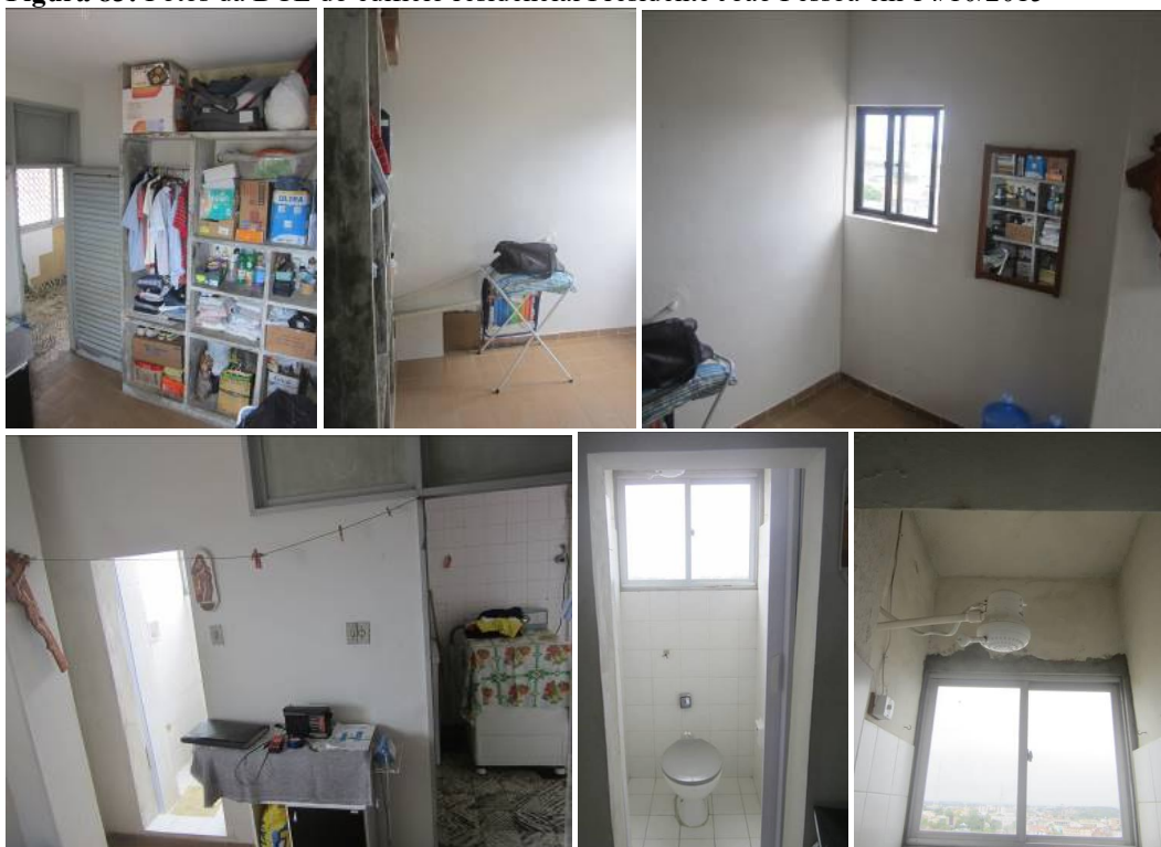
Figura 83: Fotos da DCE do edifício residencial Presidente João Pessoa em 14/10/2015
