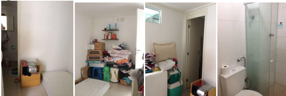
Figura 133: Fotos da DCE do edifício residencial Porto Di Bari em 13/12/2016
