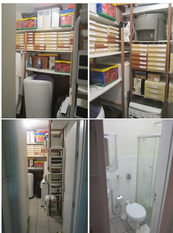
Figura 91: Fotos da DCE do edifício residencial João Marques de Almeida em 05/10/2015
