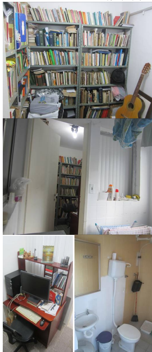
Figura 97: Fotos da DCE do edifício residencial Estrela de Ouro em 03/10/2015
