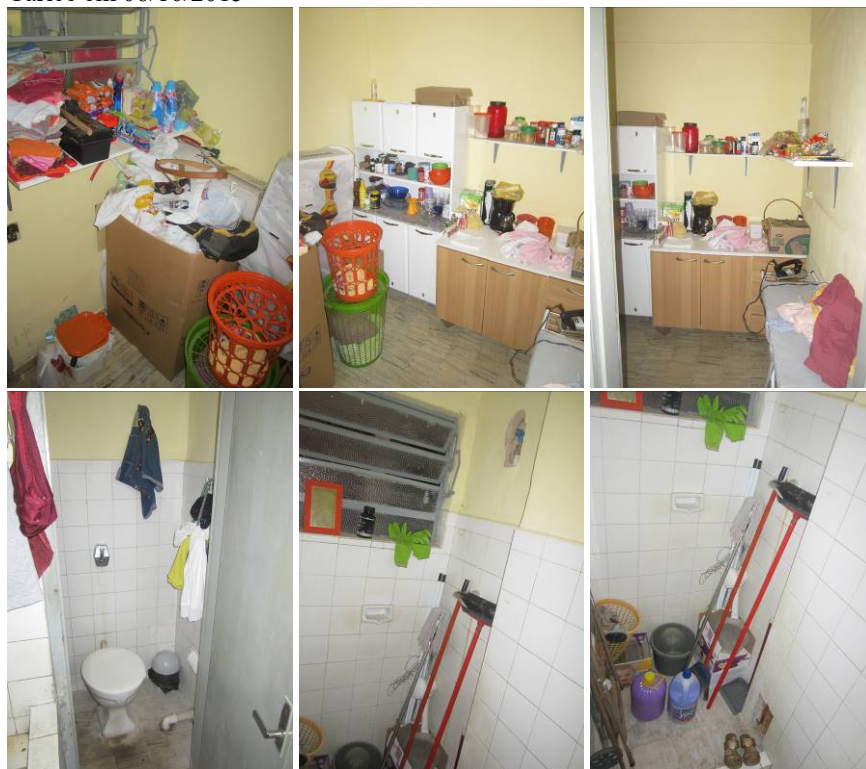
Figura 87: Fotos da DCE na tipologia “Médio 2 Eixo Sul” do edifício residencial Caricé em 06/10/2015
