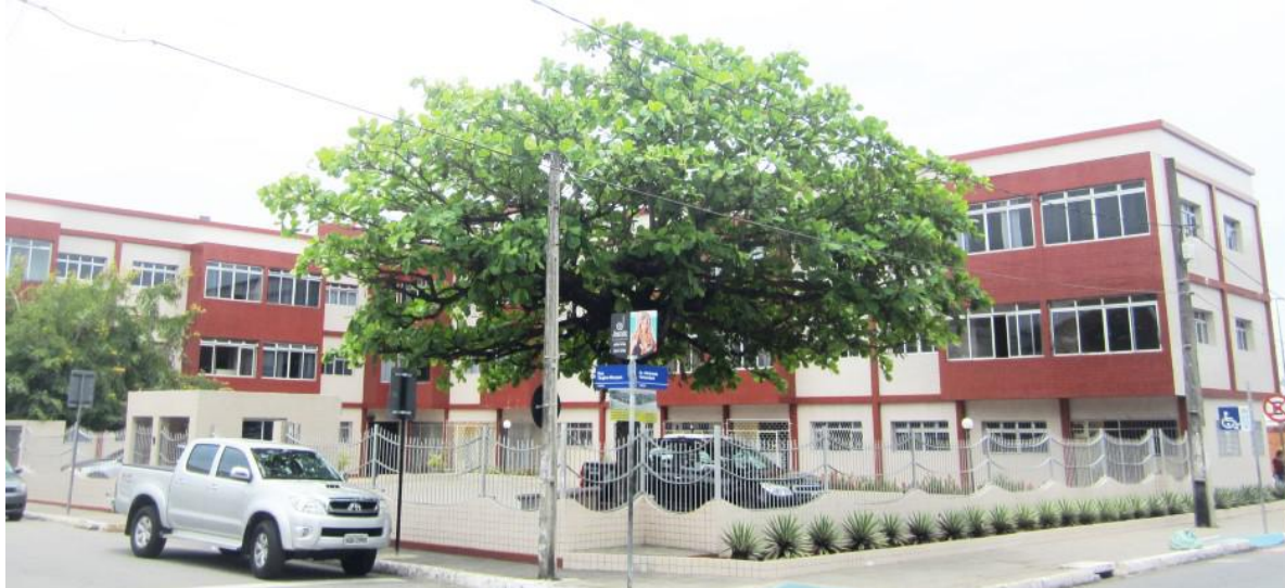
Figura 28: Edifício Santo Antônio em 2015
