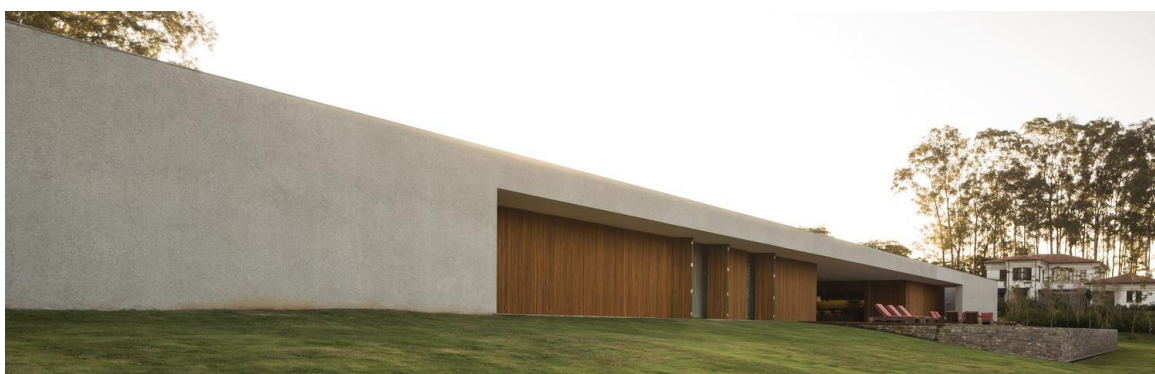
Figura 15. Fachada leste com parte dos muxarabis abertos.
