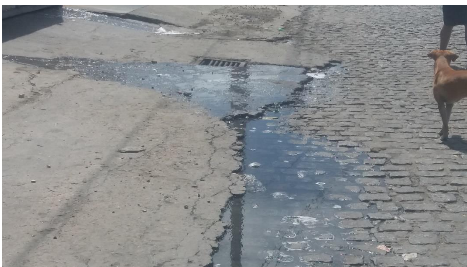
Figura 17 - Lançamento de esgoto doméstico em via pública do bairro de Intermares, cidade de Cabedelo.
