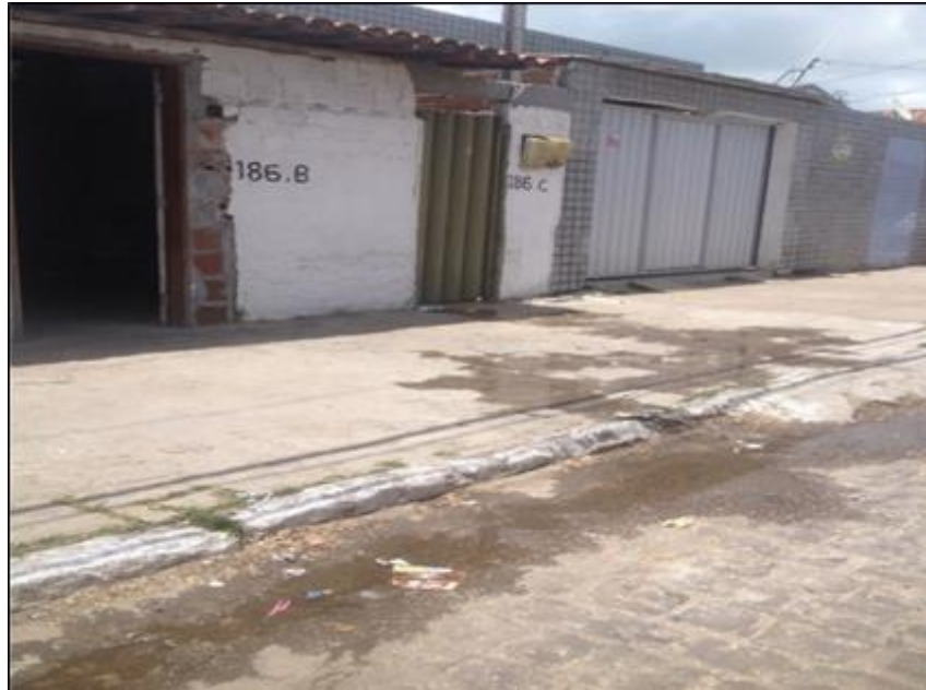
Figura 23 – Lançamento de esgoto doméstico em via pública da cidade do Conde Foto: autora (23/09/2016).
