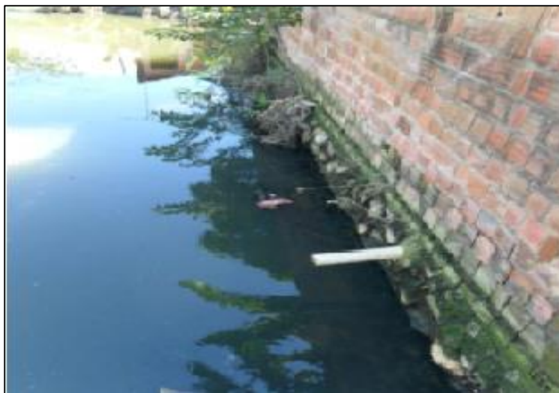
Figura 15 – Despejo clandestino de esgoto doméstico no rio Jaguaribe em João Pessoa.
