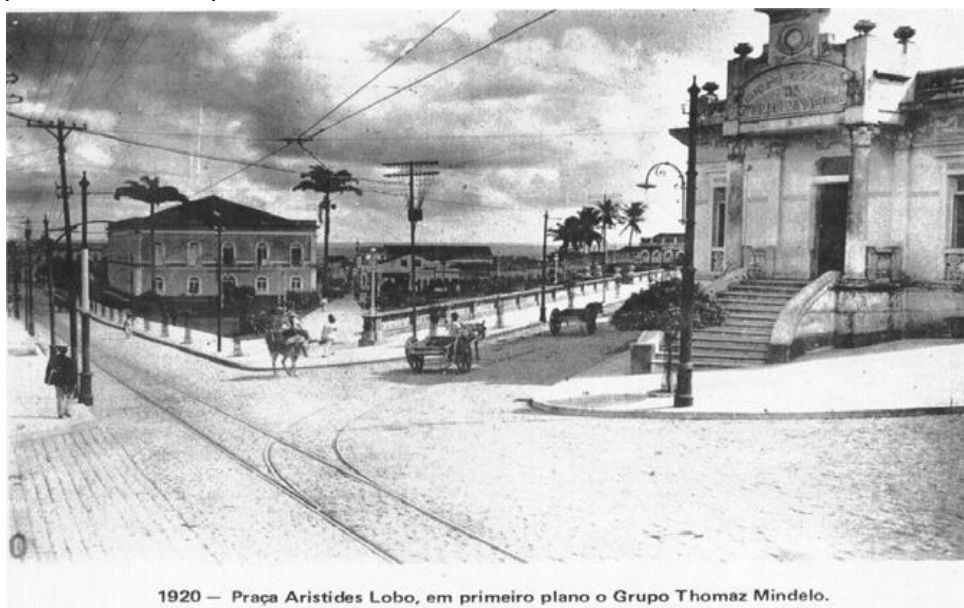
Foto 01 – Visão parcial da frente do Grupo Escolar Dr. Thomaz Mindello (à direita da foto). 32
