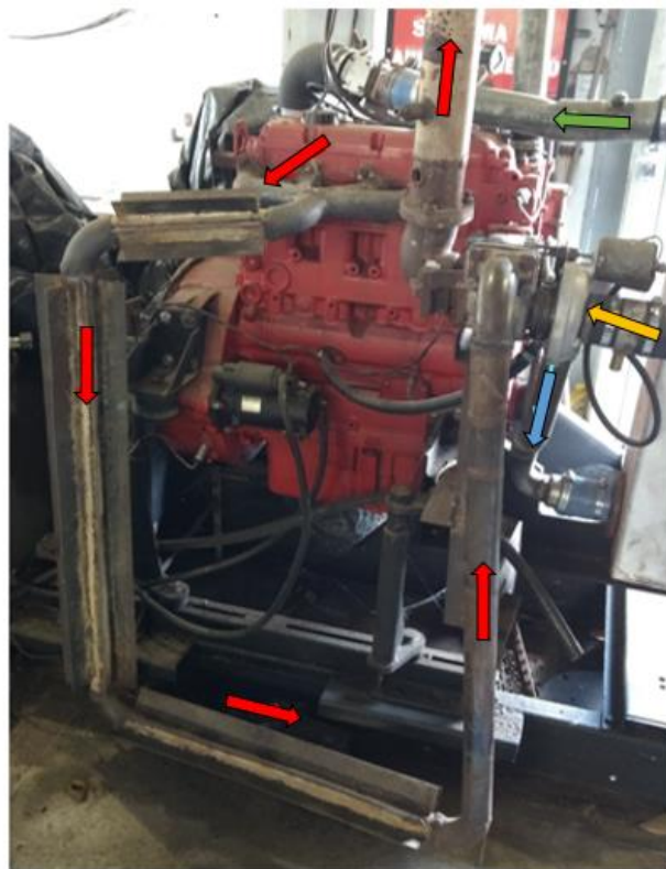
Figura 5.2 – Instalação do trocador de calor de tubo aletado.
