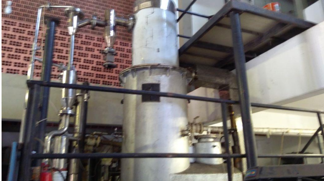
Figura 16. Gaseificador Instalado no LI-UFPB
