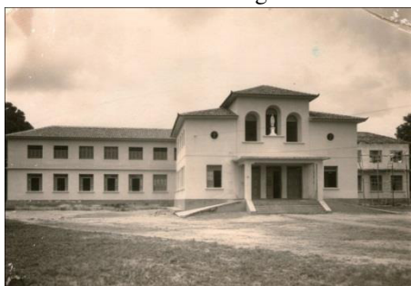
Figura 17- Fachada do Prédio do Colégio Lourdinias em construção
