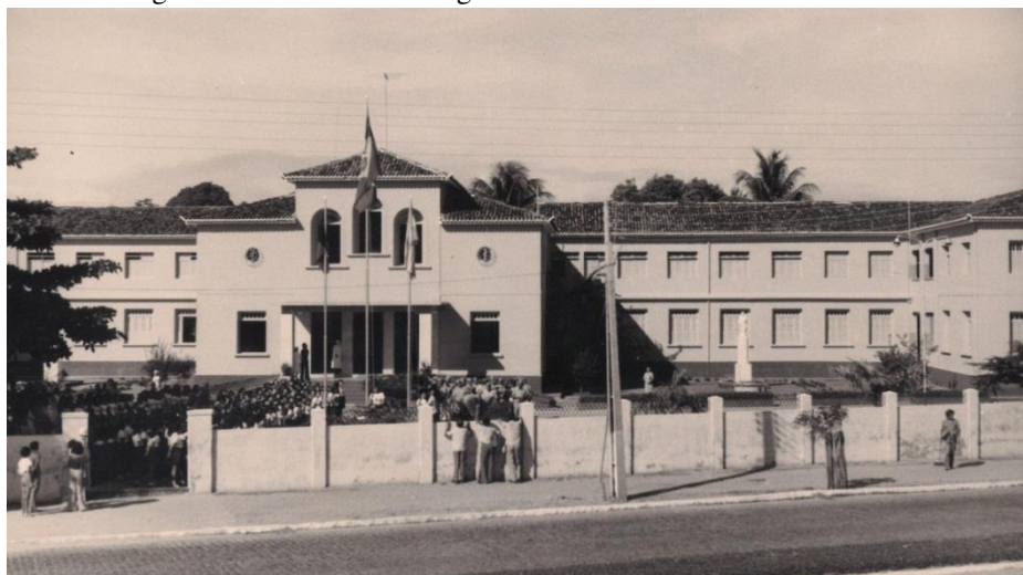
Figura 37- Fachada do Colégio Lourdinas no ano de 1976
