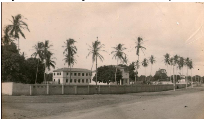
Figura 18 - Entrada do Colégio Lourdinas durante a construção
