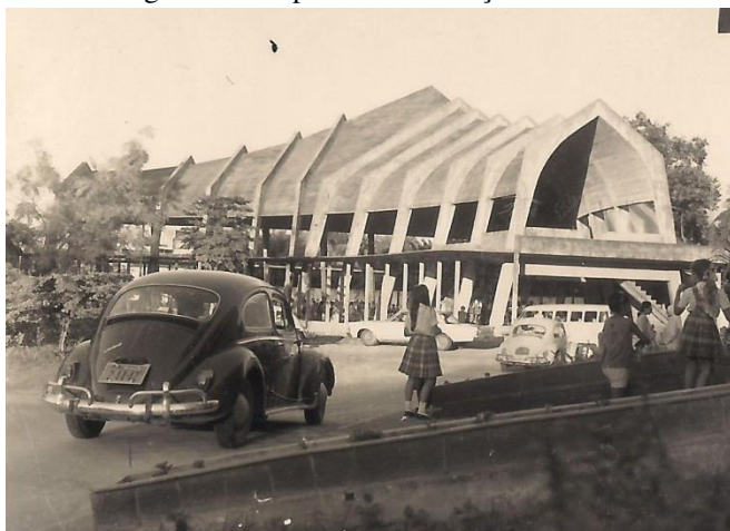
Figura 32 - Capela em construção
