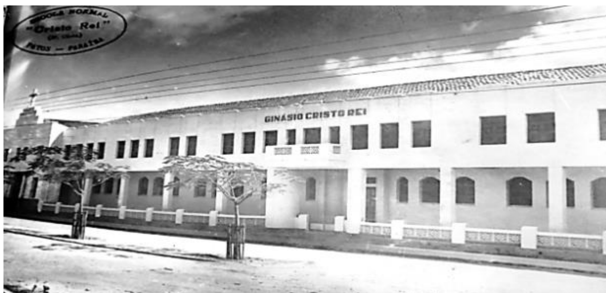
Imagem 22: Fachada da Escola Normal Cristo Rei, em Patos, cidade do interior da Paraíba
