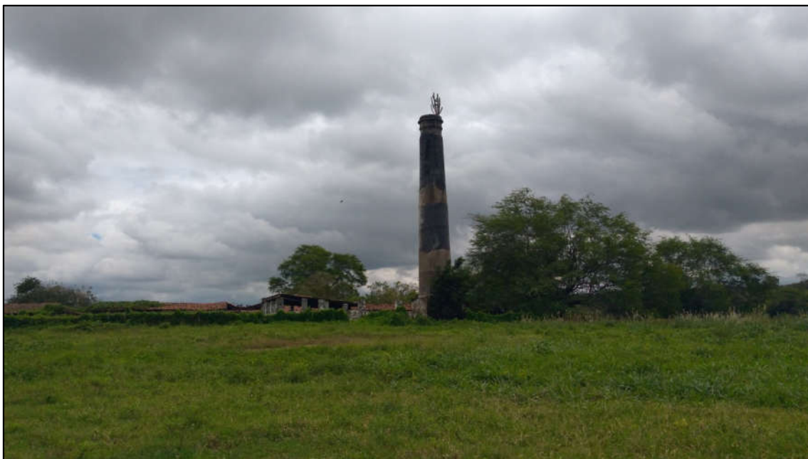
Figura 17. Ruínas do Engenho Recreio, município de Pilar-PB. Fonte: trabalho de campo.
