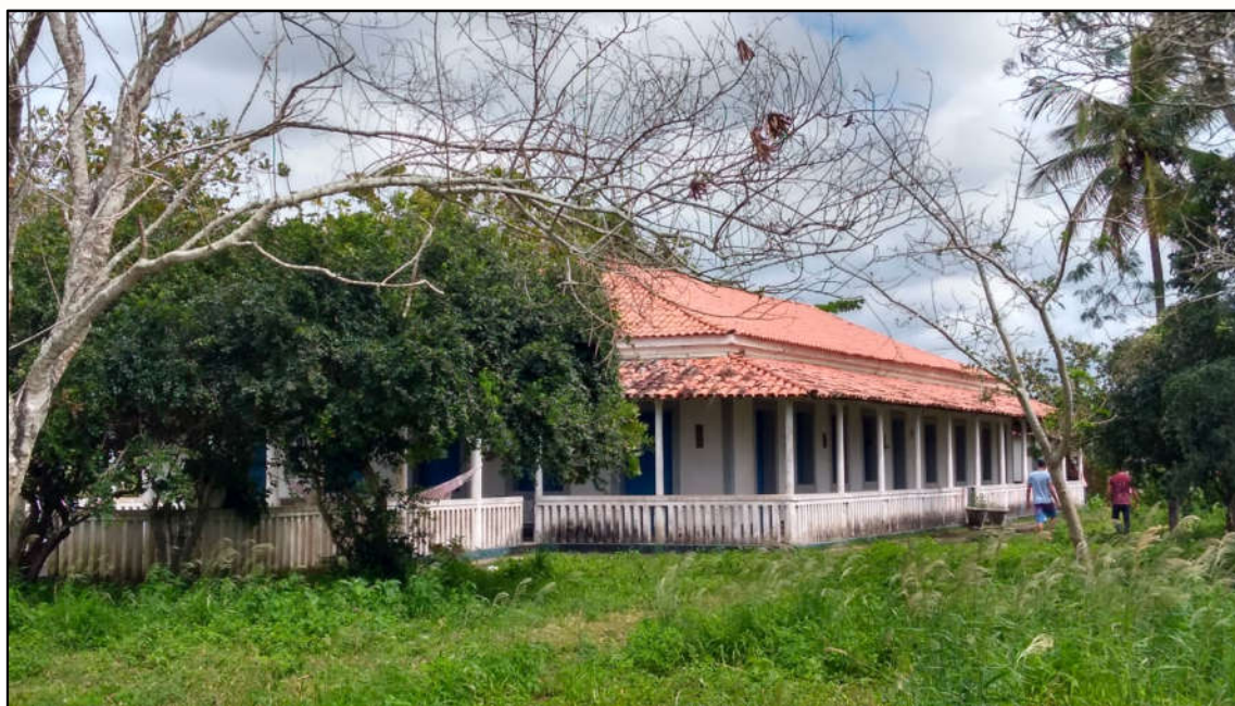
Figura 16. Vista lateral da casa grande do Engenho Recreio onde Aguinaldo Velloso Borges nasceu e viveu. Fonte: trabalho de campo.
