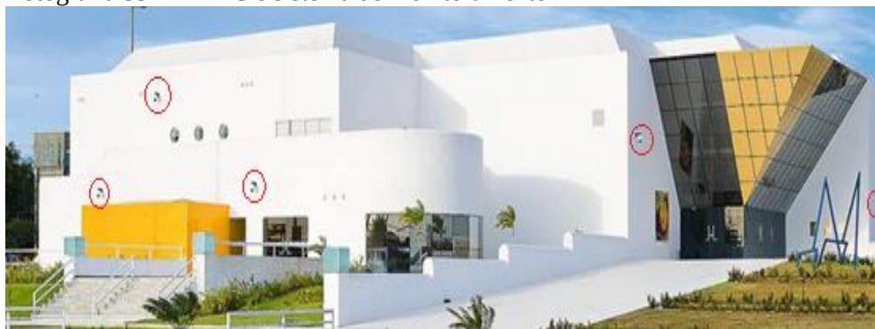
Fotografia 39 - MAAC e sistema de monitoramento
