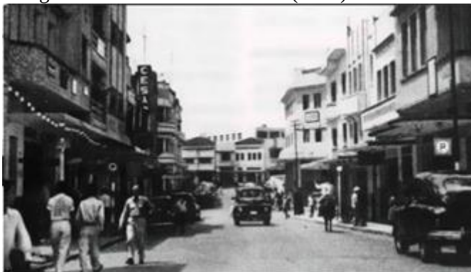
Fotografia 9 - Rua Cardoso Vieira (1946).
