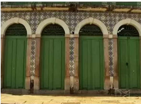
Figura 3 – Fachada do Casarão do período colonial em São Luís.
