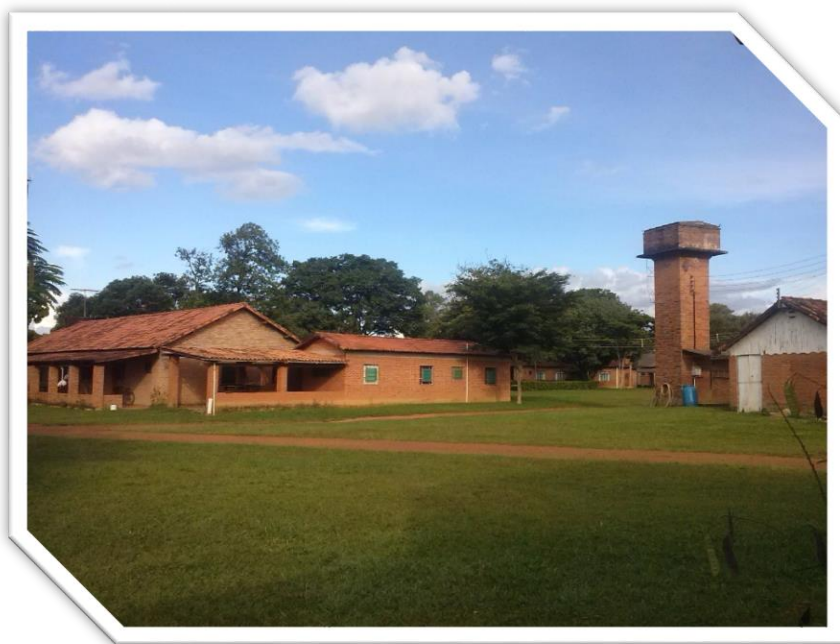
Figura 10- Foto da oficina de trabalho e da casa das solteiras.
