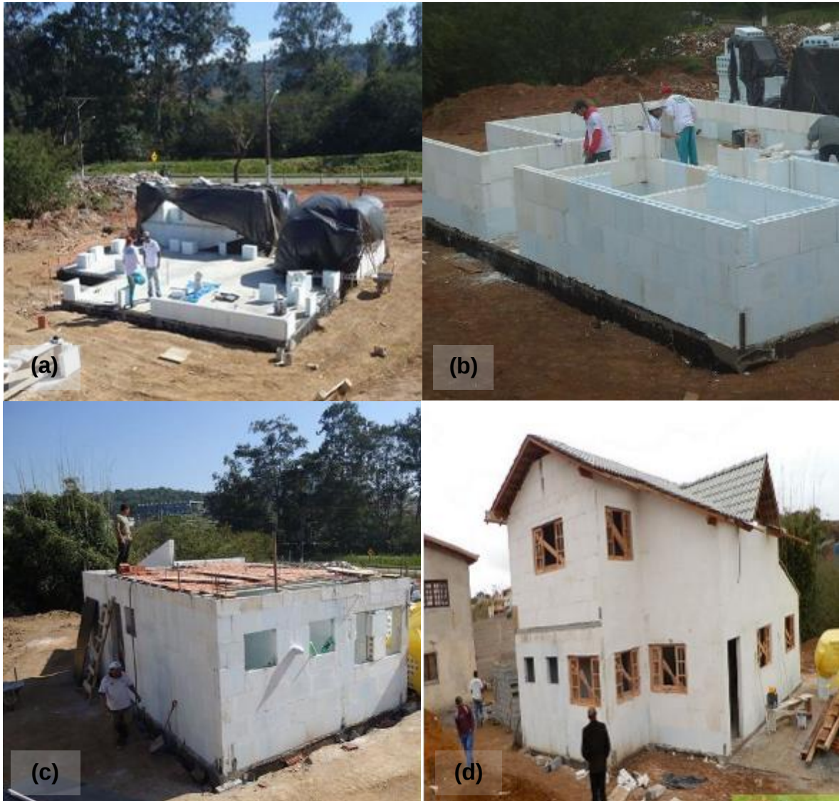
Figura 7 - Construção de habitação de padrão médio com blocos de gesso. (a) Execução da primeira fiada com blocos hidrofugados. (b) Elevação da alvenaria dos blocos. (c) Colocação da laje. (d) Habitação com dois pavimentos e cobertura em telha cerâmica.
