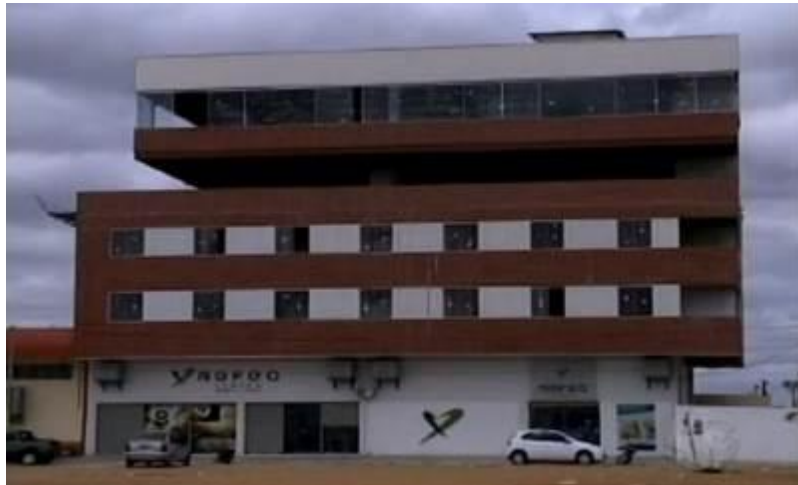
Figura 4 – Edifício construído com blocos de concreto e garrafas PET
