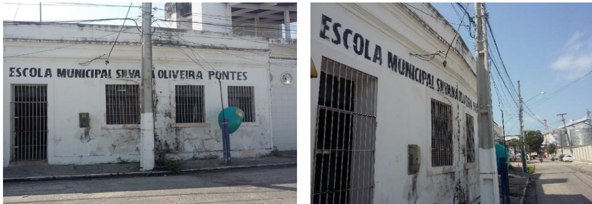
Figura 4: Fachada e visão lateral da EMEF Silvana Oliveira Pontes em Cabedelo – PB.
