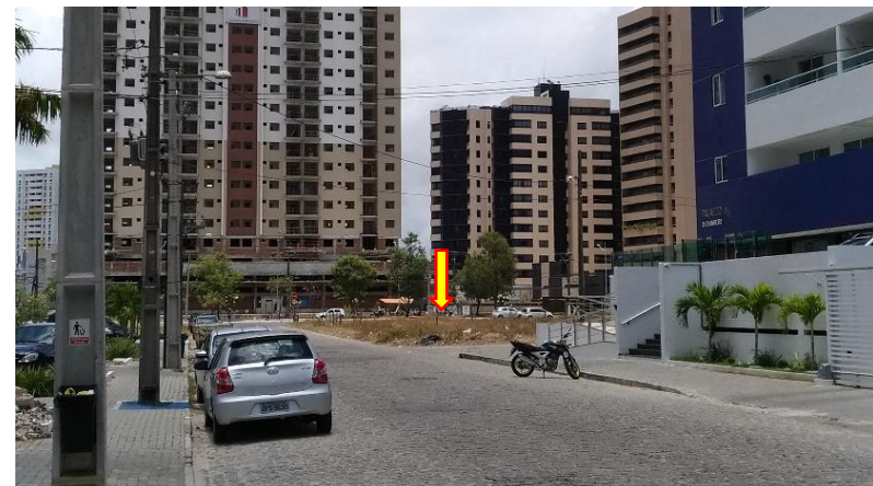
Figura 14 – Vista do terreno
