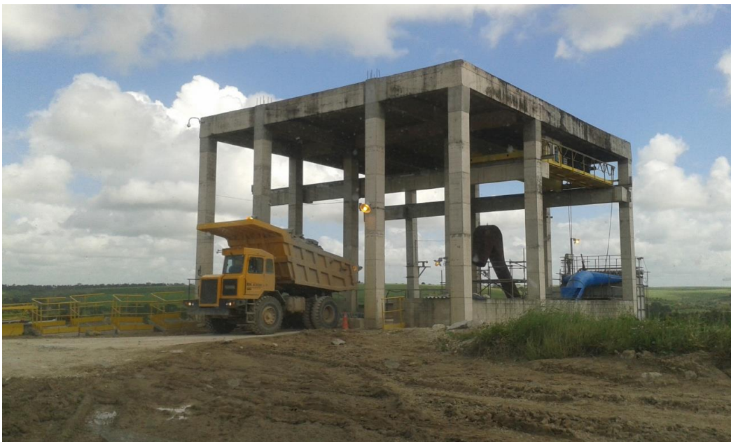
Figura 3. Caminhão descarregando calcário para o britador.
