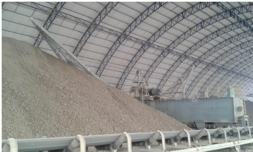
Figura 7. Armazém de matéria-prima.
