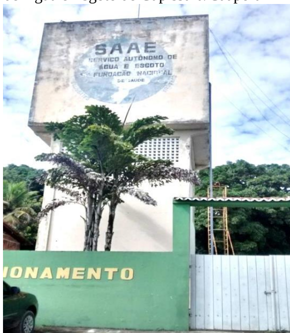
Fotografia 04 - Reservatório do Serviço Autônomo de Água e Esgoto de Cupissura/Caaporã - PB
