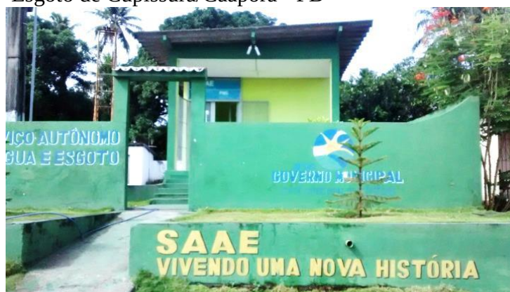
Fotografia 03 – Sede do Serviço Autônomo de Água e Esgoto de Cupissura/Caaporã - PB
