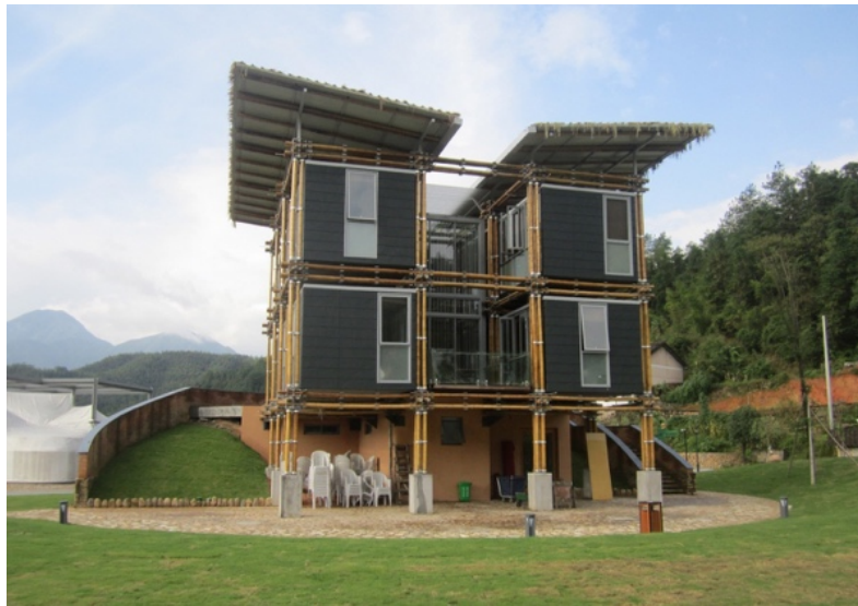
Figura 16 – Residência em bambu energeticamente eficiente. Fonte: Archdaily (2018).
