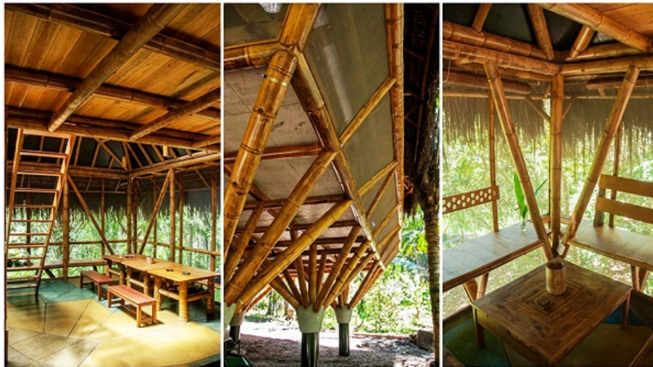
Figura 14 – Interior do albergue. Fonte: SustentArqui.com (2018).
