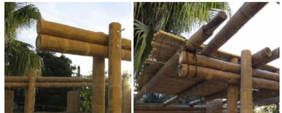
Figura 06 – Faceamento entre viga e pilar. Fonte: Carvalho (2014).
