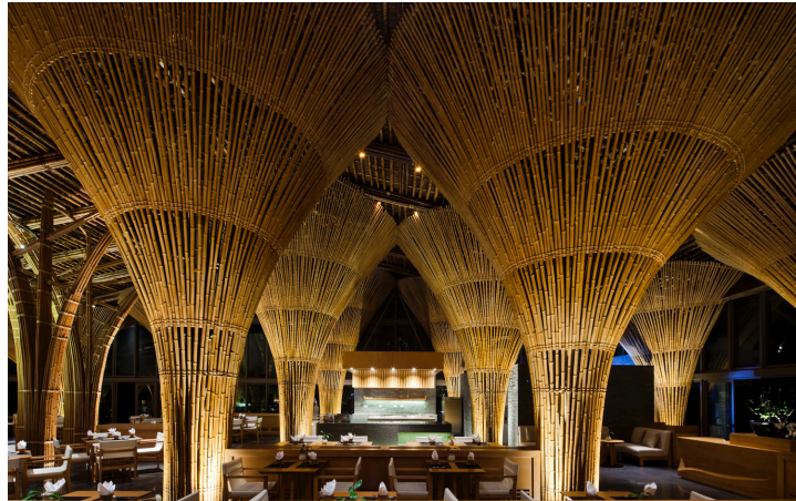
Figura 09 – Estrutura do restaurante em bambu. Fonte: Archdaily (2018).
