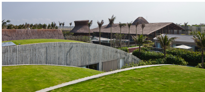
Figura 07 – Vista do Naman Retreat. Fonte: Archdaily (2018).
