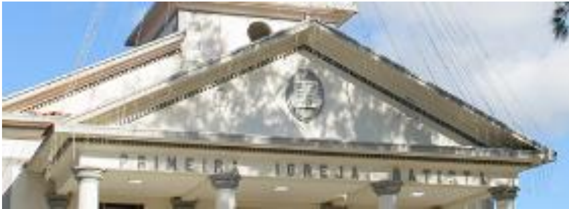
(Foto 14- Colunas e 15- Estrutura da Igreja)
