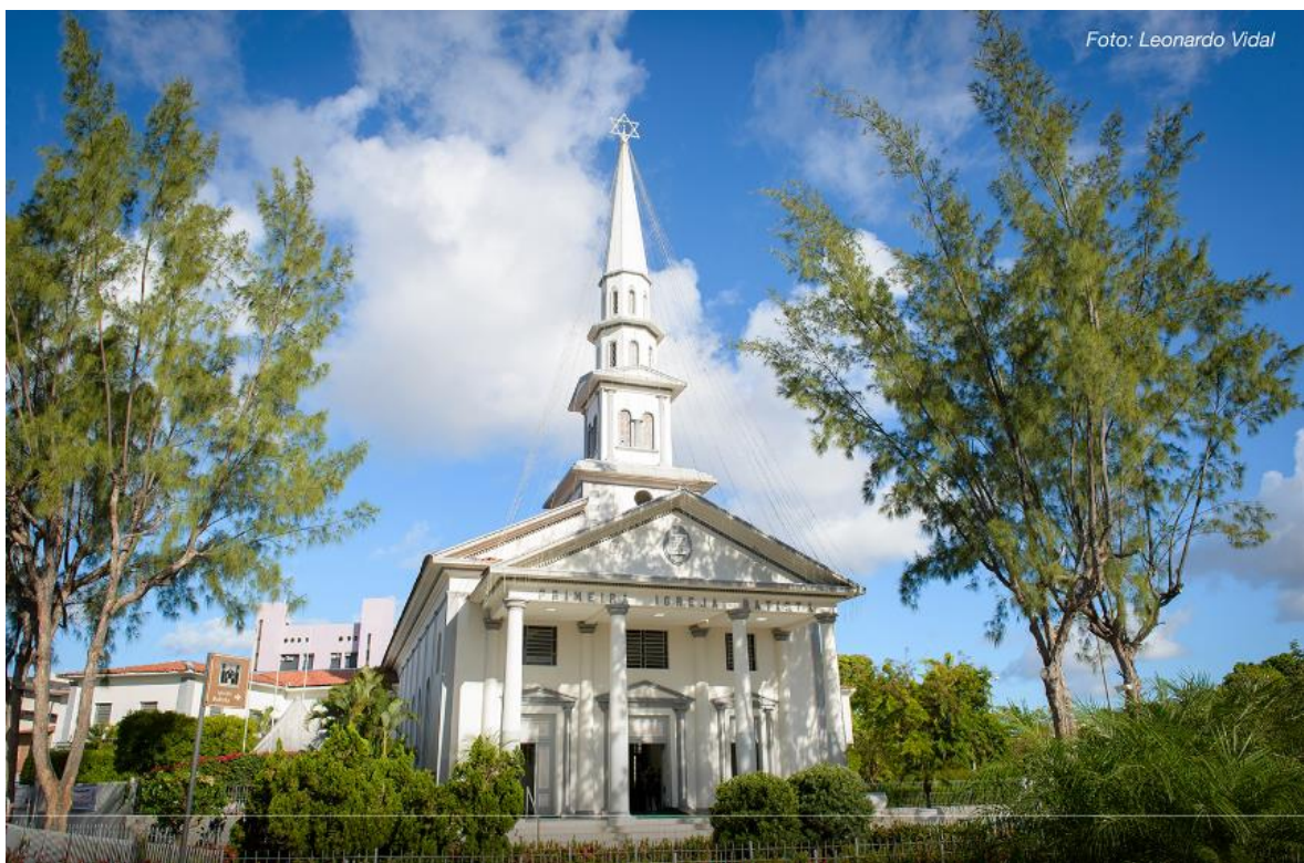
(Foto 12- Fachada principal)
