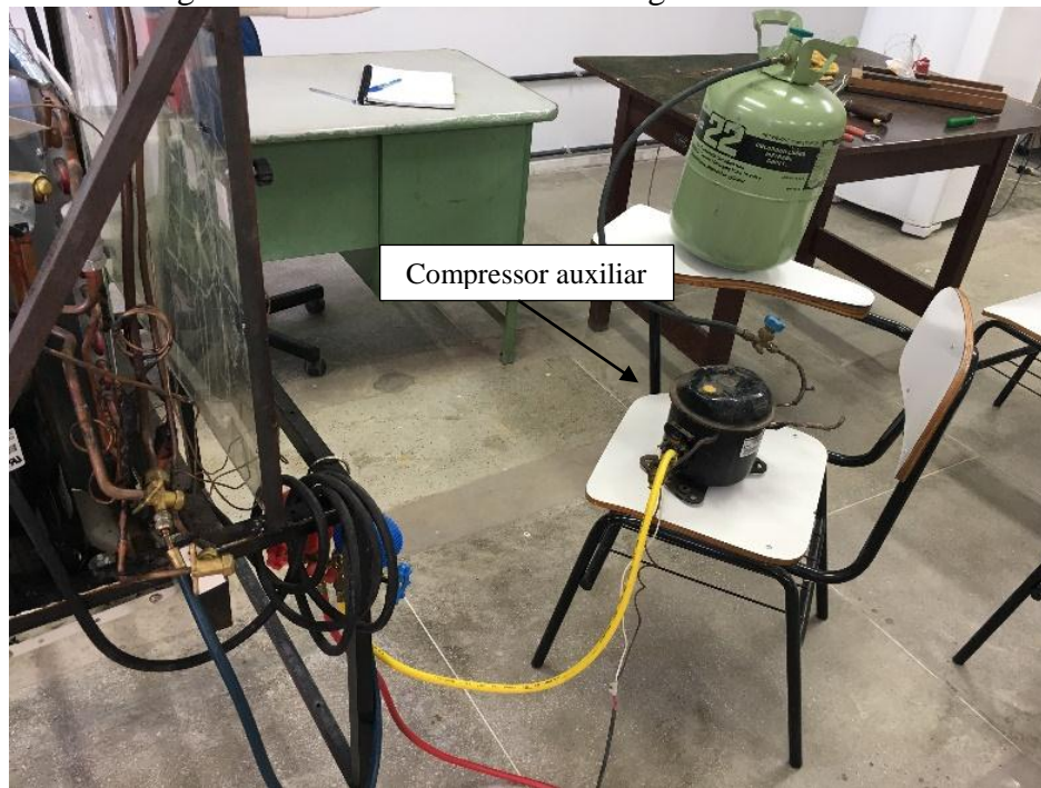
Figura 11 – Retirada de fluido refrigerante do sistema
