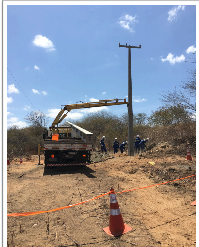
Figura 5 - Implantação de poste no município de Ipanguaçu
