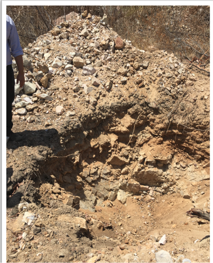
Figura 4 – Escavação com explosivos na cidade de Itajá
