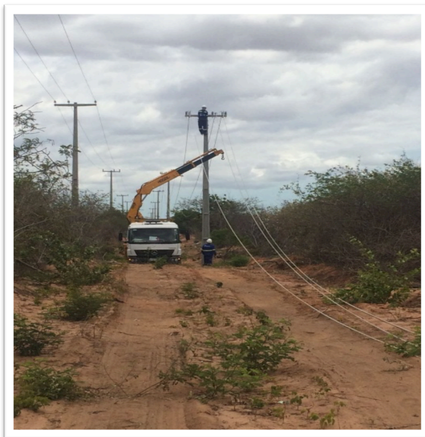
Figura 7 – Lançamento de cabos em zonas rurais
