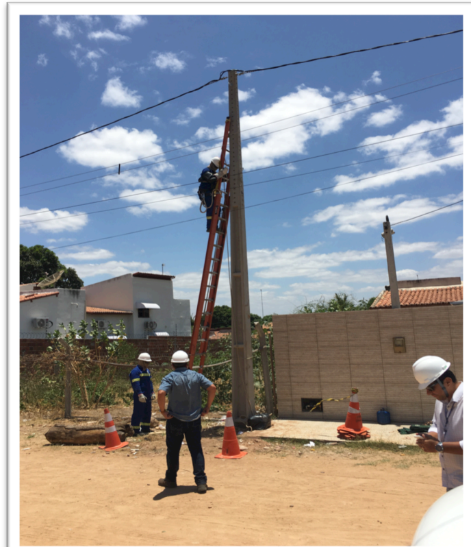
Figura 6 - Lançamento de cabos em redes urbanas em Açú
