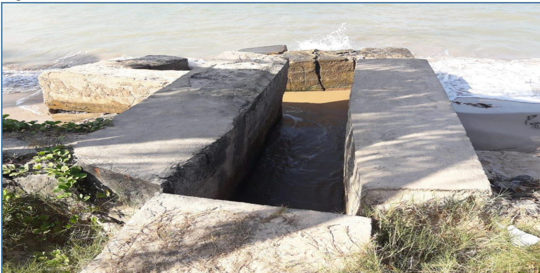
Figura 14- GALERIA DO PONTO 06. 04.C.
