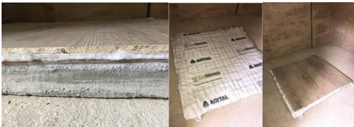
Figura 16 - Piso laminado de madeira com manta acústica sobre piso original cerâmico para ensaio simplificado – LaMacCe.
