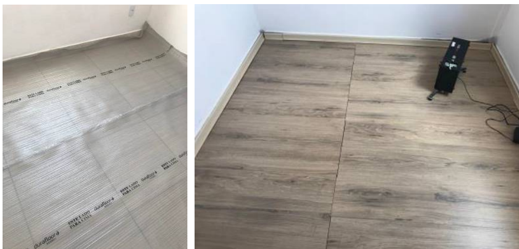
Figura 20 - Manta original e novo piso laminado de madeira sobre piso original de cerâmica em campo – LaMoCeCamp.
