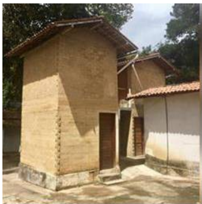
Figura 3 – Câmaras acústicas (1 – na frente; 2 – ao fundo) onde foram realizados os ensaios simplificados.
