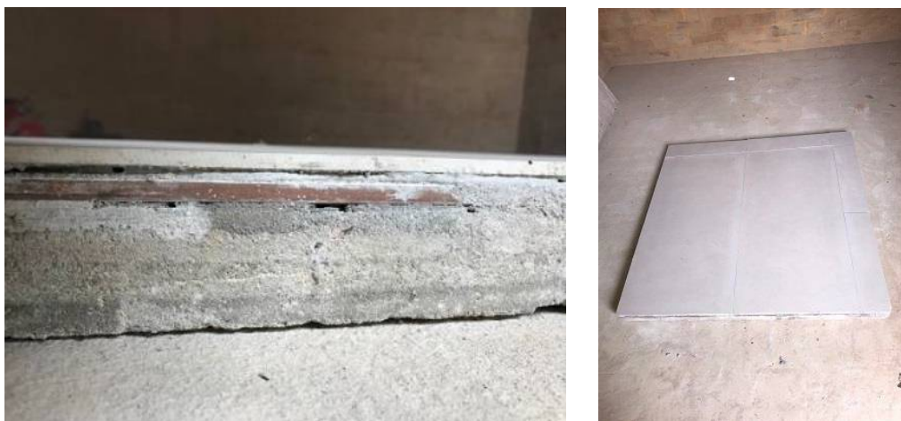
Figura 18 - Novo piso de porcelanato sobre o piso original de cerâmica para ensaio simplificado – PorCe.
