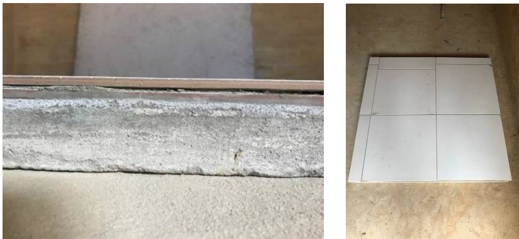
Figura 17 - Novo piso de cerâmica sobre o piso original de cerâmica para ensaio simplificado – CeCe.
