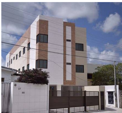
Figura 9 - Edifício onde foi realizado o ensaio em campo.
