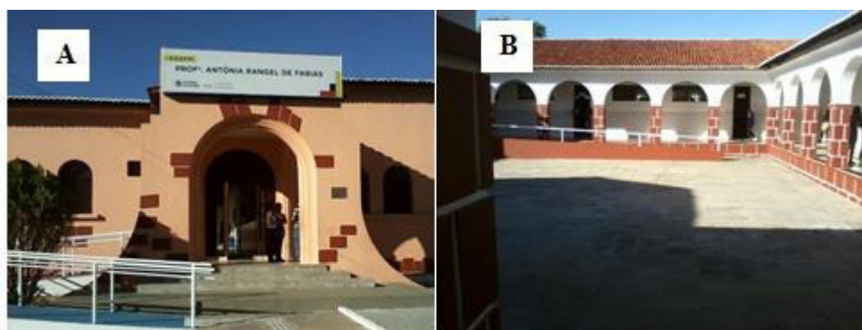
Figura 1: Estrutura da EEEFM Professora Antônia Rangel de Farias, localizada no bairro Torre, João Pessoa – PB. (A – Entrada principal; B – Pátio da escola).
