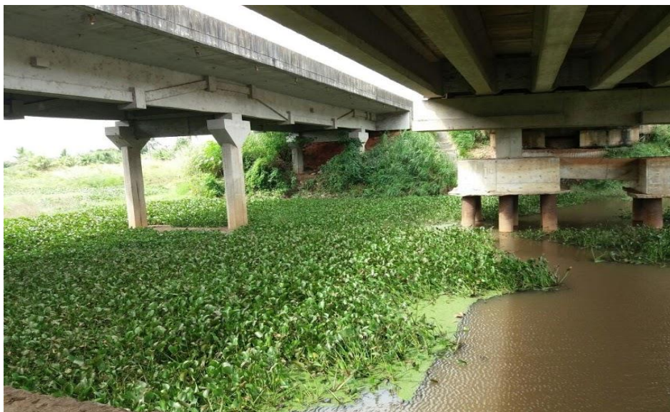
Figura 4. Ponto 3: Ponte na BR 101, Km 80, Santa Rita-PB. Fonte: Acervo da autora.
