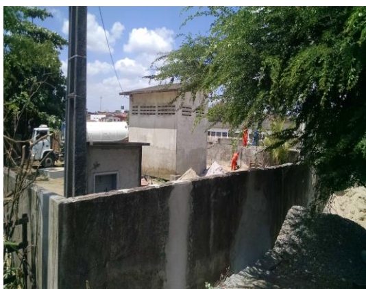
Figura 10. Estação elevatória da CAGEPA, próximo ao Ponto 2 (P2) no mês de dezembro de 2016, na Av. Anísio Pereira Borges, centro da cidade de Santa Rita-PB. Fonte: Acervo da autora.
