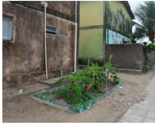
Figura 20. O sistema do TEVAP, após as etapas de preenchimento das camadas, Construção de um rebordo no tanque dois meses após a sua instalação no Condomínio Amizade, Paratibe, João Pessoa, PB.
