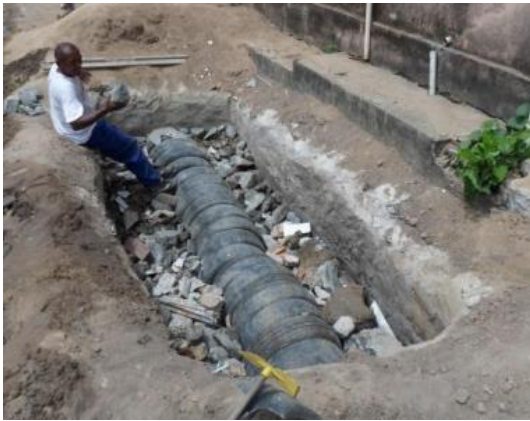
Figura 19. Preenchimento do TEVAP com metralha, após as etapas de perfuração, impermeabilização com tela e cimento, e colocação de pneus para fazer a câmara que receberá o esgoto bruto de residências no Condomínio Amizade, Paratibe, João Pessoa, PB.
