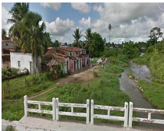
Figura 5. Ponte da Rua Amaro Coutinho, centro da cidade de Santa Rita-PB.
