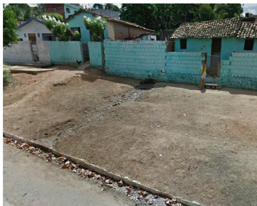
Figura 7. Exemplo de residência com lançamento de esgoto a céu aberto próximo à Rua Maria da Paz Lacet, Santa Rita-PB. Fonte: Google Earth.
