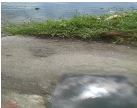
Figura 6. Boca de lobo na barragem do Rio Tibirizinho, início do trecho do Rio Preto, Santa Rita-PB no mês de fevereiro de 2017. Fonte: Acervo da Autora.
