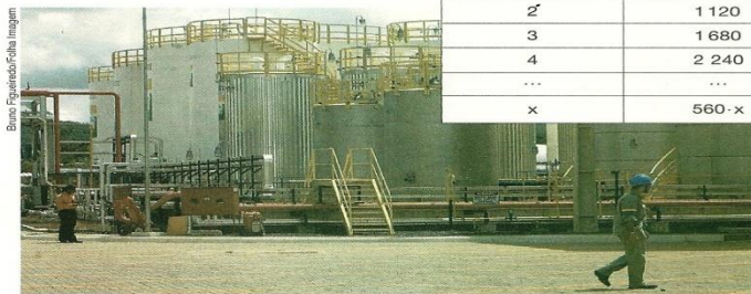
Usina de biodiesel em Montes Claros-MG (6/4/2009).
