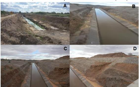
Figura 22 - Obras da trasposição do Rio São Francisco no município de Monteiro/PB, evidenciando os processos erosivos no canal (C e D).
