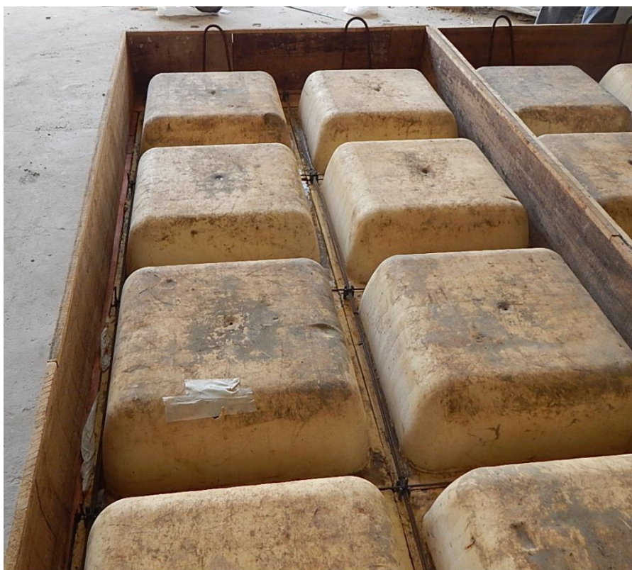
Figura 21 - Forma da laje nervurada com a grelha, espaçadores e ganchos já posicionados.
