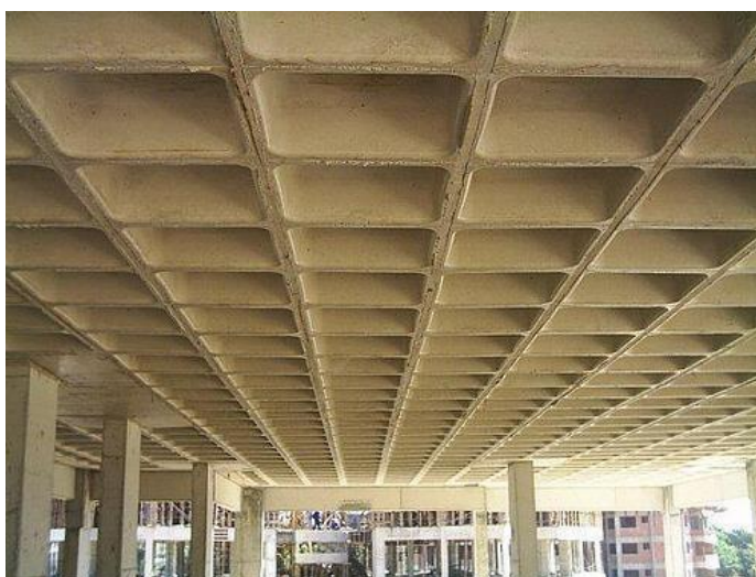
Figura 20 – Laje nervurada moldadas com caixotes plásticos. (Fonte: Google Imagens).
