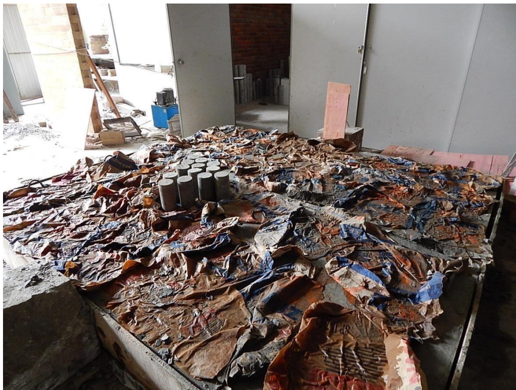
Figura 23 – Cura das lajes nervuradas e de seus corpos de prova
