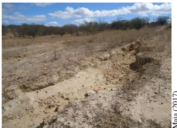
Figura 7. Presença de voçoroca na área CAH.
