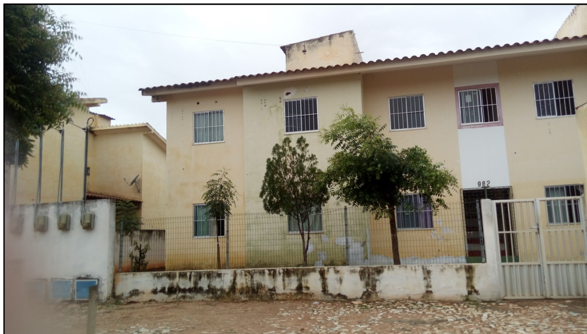
Figura 32: Vista externa do empreendimento 01 em Russas. Foto: Pesquisa de campo – Sousa (2018).
