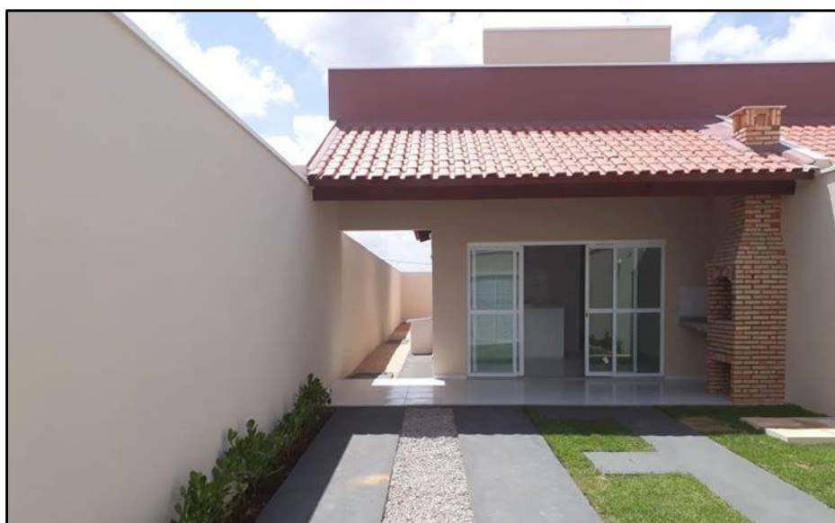
Figura 21: Casas para vendas no Loteamento Bela Vista. Foto: Sousa (2018) – Trabalho de Campo
