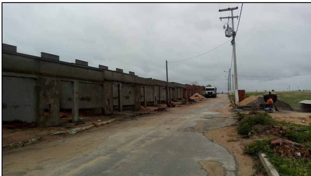
Figura 20: Construção de casas no Loteamento Bela Vista. Foto: Sousa (2018) – Trabalho de Campo
