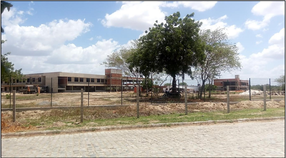
Figura 06: Obras de expansão no campus universitário – UFC/Russas. Fonte: Acervo próprio – Sousa (2018) – Trabalho de Campo – Março – 2018.
