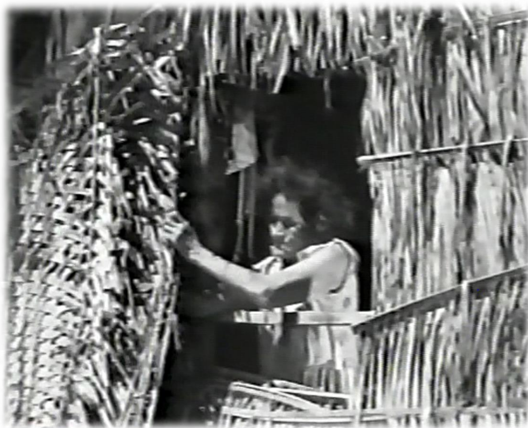
Figura 19: Casa de palha de coqueiro localizada em Cabedelo da década de 1960.
