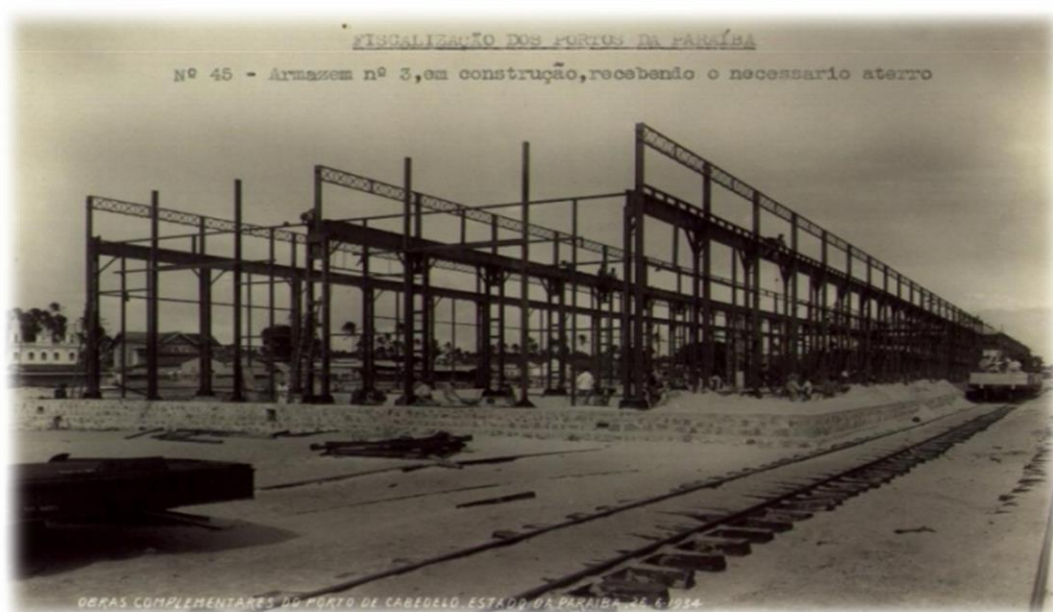
Figura 7: Construção de armazém no porto de Cabedelo-PB, em 1934.
