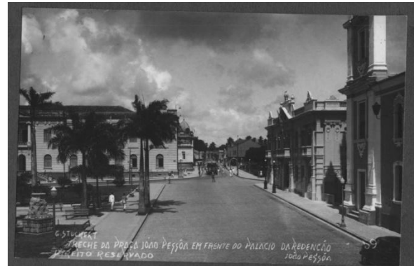
Figura 52: Palácio, s/a. Fonte: Stuckert.
