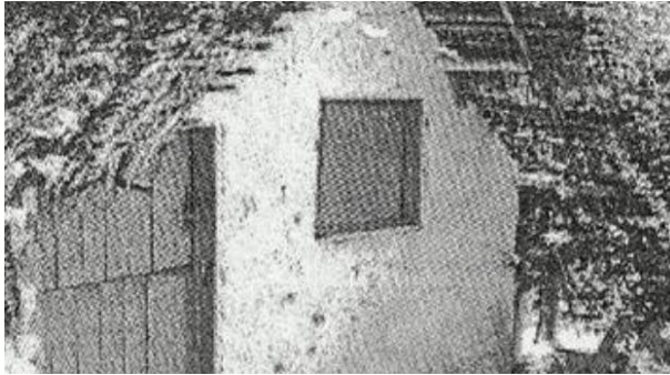
Figura 57: Casa de palha em Jaguaribe. Fonte: Ribeiro, 2000.
