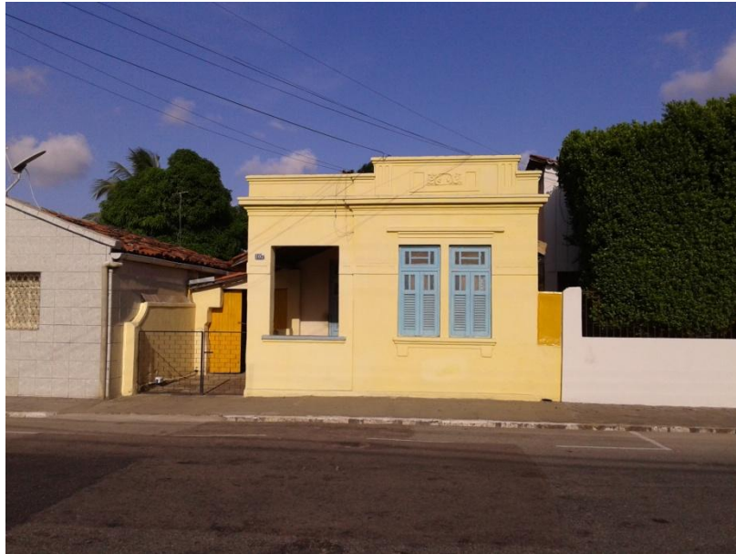
Figura 15: Casa localizada na Avenida Aderbal Piragibe. Fonte: Autor, 2015.
