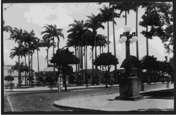
Figura 53: Iluminação no Jardim Público. Fonte: Stuckert.
