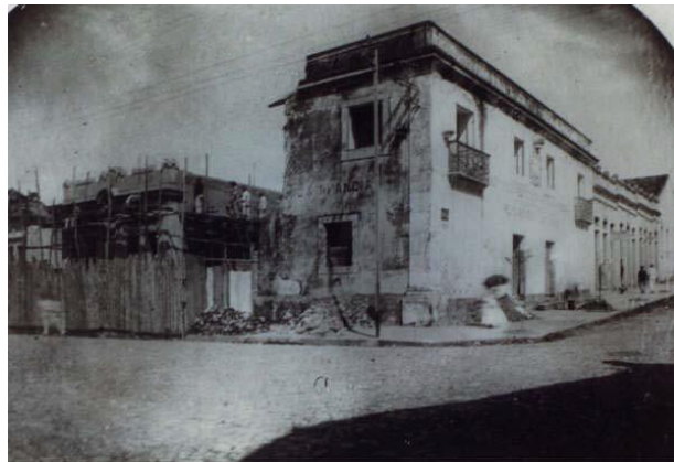
Figura 19 – Demolição do antigo prédio do hospital de caridade, na Visconde de Pelotas.
