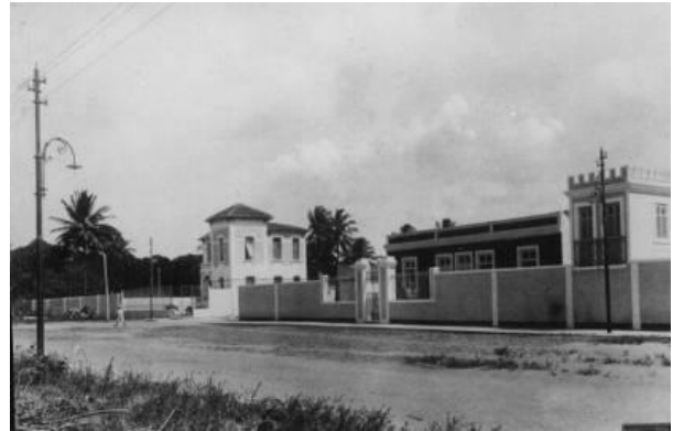
Figura 28 - Trecho da Avenida João Machado.
