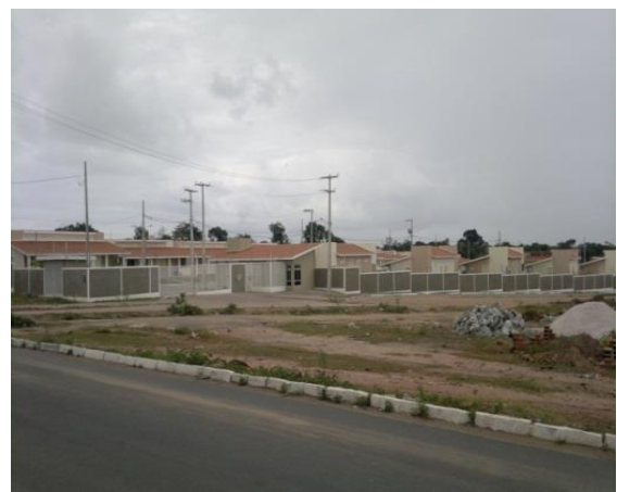
Figura 9. Condomínio Habitacional Cidade Madura já concluído, João Pessoa - PB. Fonte: Tainandra Lima
