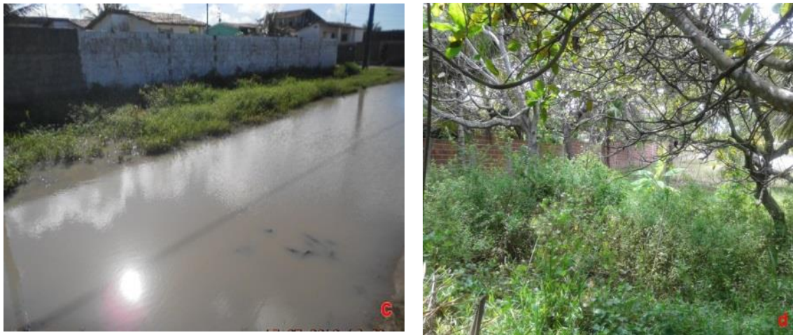
Figura 17 a) Extração mineral conhecida por “Areal” na Mata de Jacarapé no entorno do Aratú. b) Extensão da área e, ao fundo o Condomínio Cidade Madura. c) Impermeabilização do solo em rua próxima ao Rio Aratú. d) Construção de casas na nascente do Rio Aratú. João Pessoa – PB Foto: Tainandra Lima
