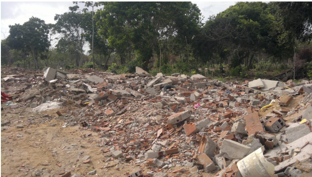
Figura 14. Casas que foram destruídas por estarem na reserva do Aratú. João Pessoa, - PB Fonte: Tainandra Lima
