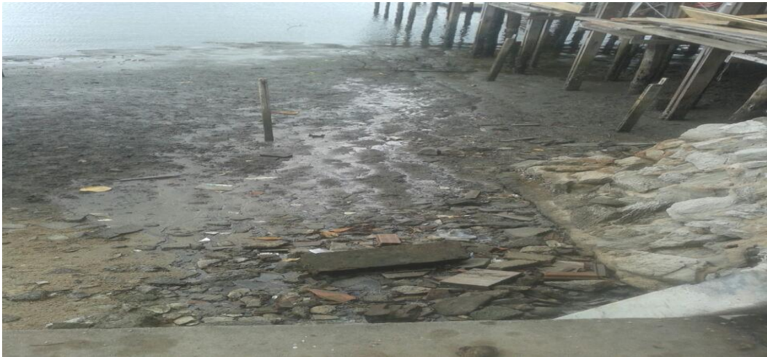
Figura 13: Esgoto sendo despejado no Rio.
