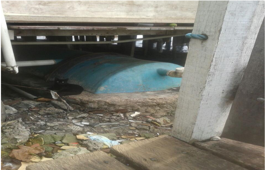
Figura 14: Reservatório localizado embaixo do Bar destinado a depósito de dejetos.
